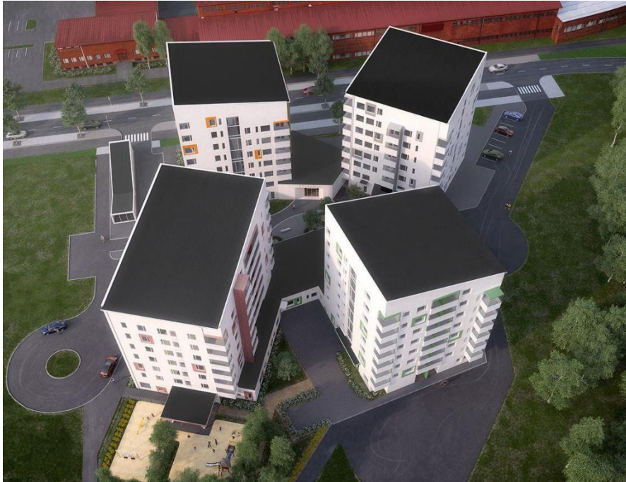
Kuva 41: Ilmakuva neljän rakennuksen kokonaisuudessa, joita yhdistävät ensimmäisen kerroksen yhteistilat (Kotikatu 365).
