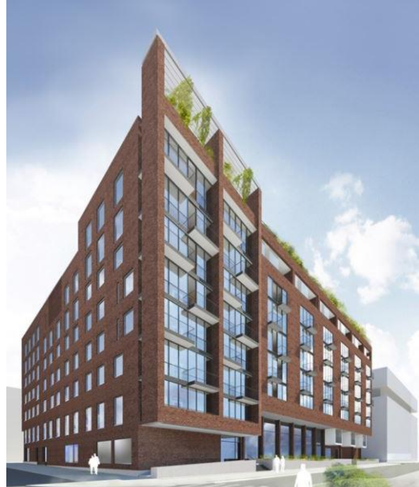
Kuva. 11: Senioreiden asuinyhteisö Kotisatama Kalasatamassa. Aktiiviset Seniorit Ry:n ryhmärakennuttama toinen kohde. Kirsi Siven & Asko Takala Arkkitehdit Oy. 2015 (Helsingin kaupungin ATT. 2014.)
