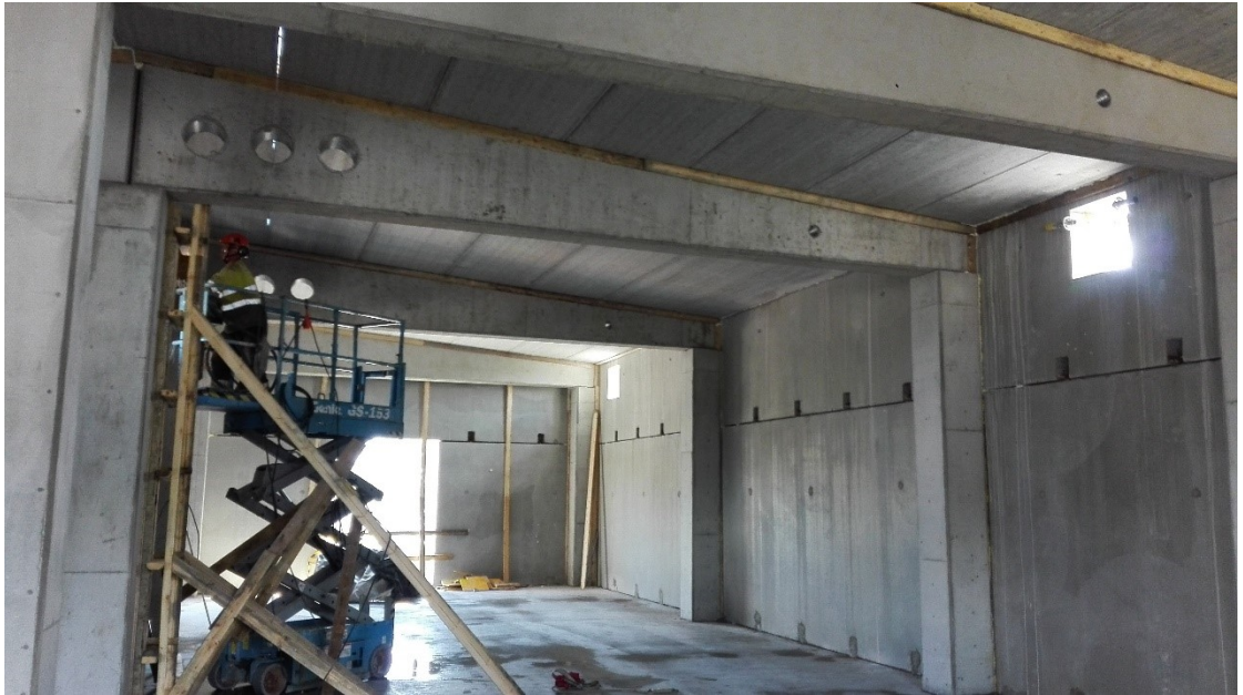
Kuva 7. Paineenpoistoaukkoja betonielementtirakenteisessa muuntamorakennuksessa (Nieminen 2019)
