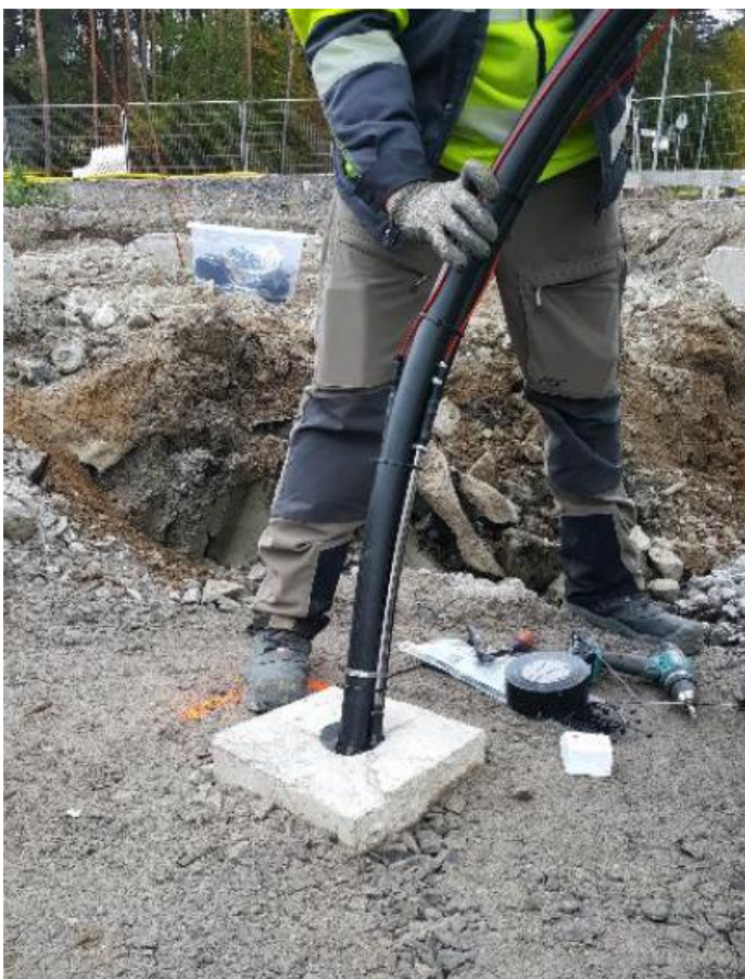
Kuva 11 Teräsbetonipaalu energiapaaluna (Brandt)
