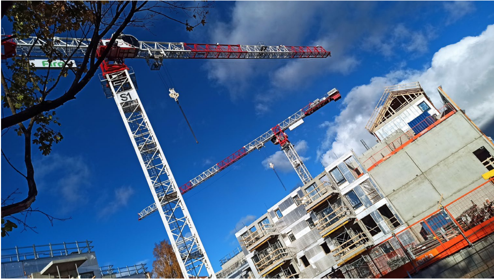
Kuva 26: Rakennustöitä alueella (Ilkka Mitrunen)
