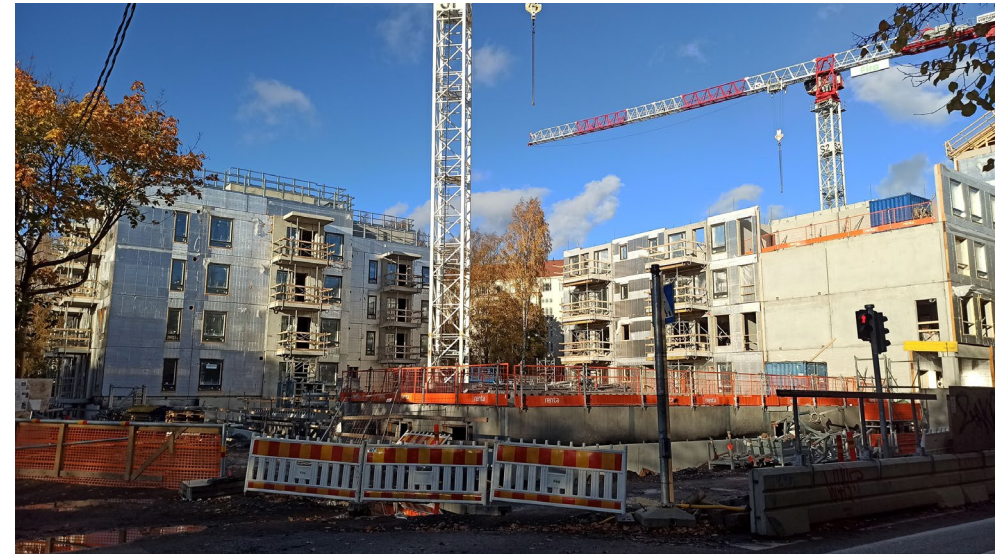
Kuva 29: Rakennustöitä alueella (Ilkka Mitrinen)
