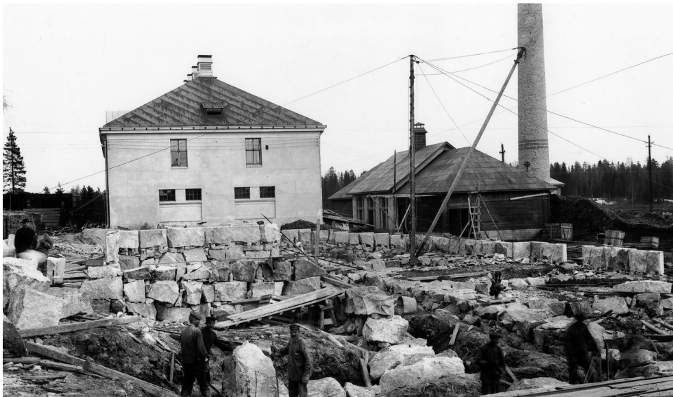
Kuva 10: Koskelan kunnalliskodin rakennustöitä vuonna 1911 (Helsingin kaupungin museo)
