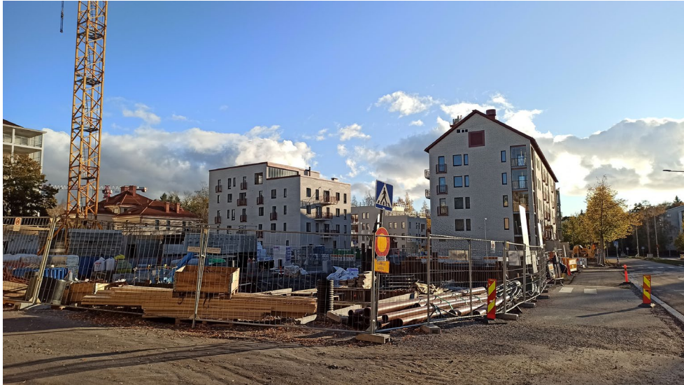
Kuva 28: Rakennustöitä alueella (Ilkka Mitrinen)
