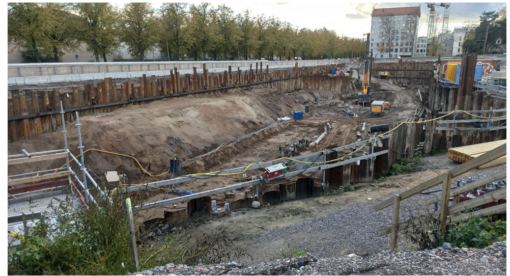
Kuva 27: Rakennustöitä alueella (Ilkka Mitrunen)
