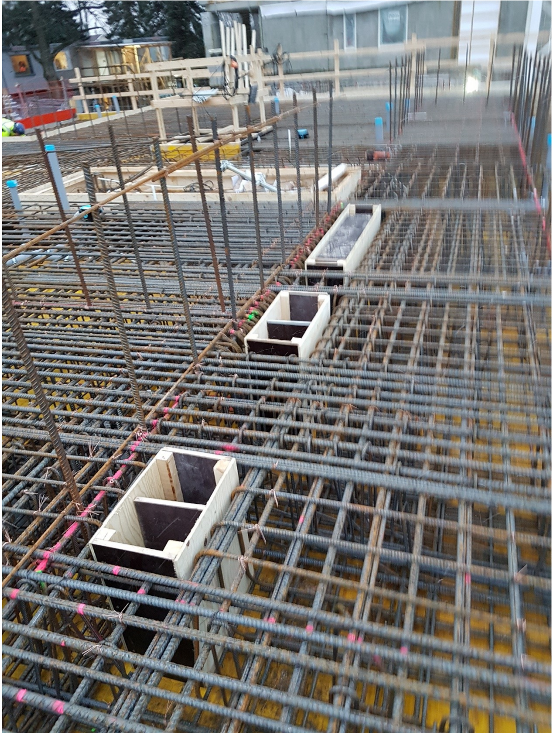
Kuva 7. LVIS-nousukuilujen varaukset tehty yli valettavan holvin pinnan.
