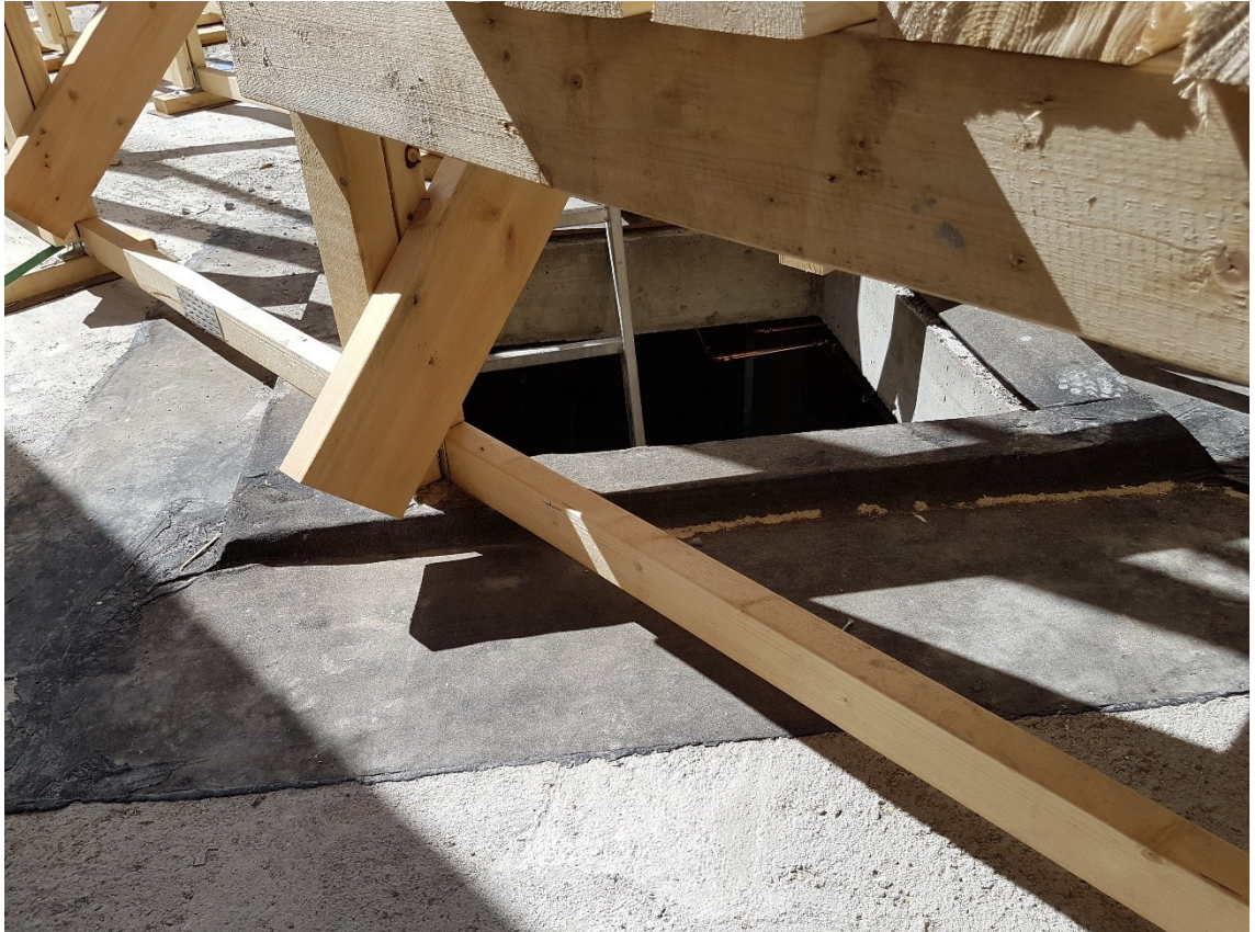
Kuva 10. Aukko padottu käyttäen bitumihuopaa ja kolmiorimaa.
