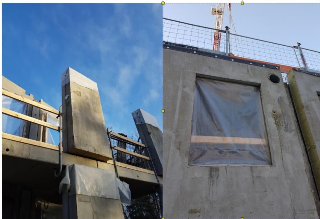
Kuva 5. Elementtien suojauksia As Oy Turun Kurjenlinnan Piha.
