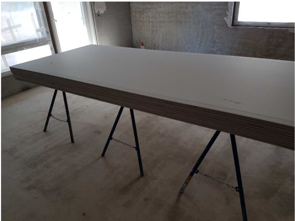
Kuva 4. Kipsilevynipun oikeaoppinen varastointi.
