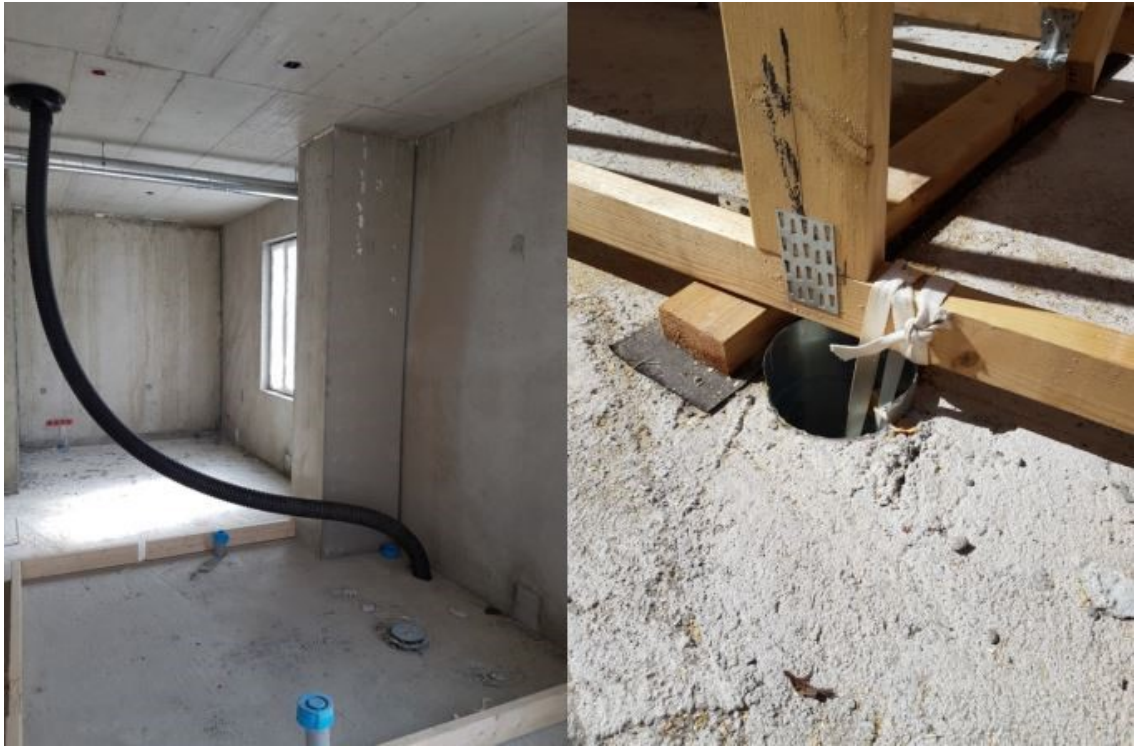
Kuva 8. Väliaikainen yläpohjan viemäröinti.
