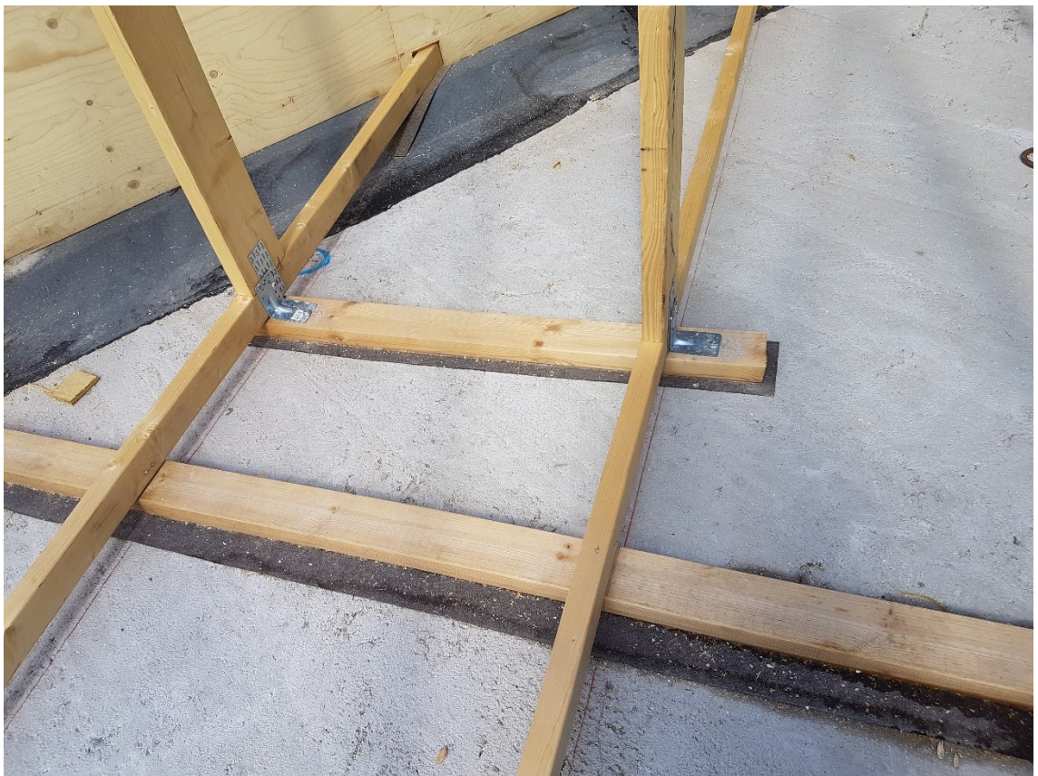
Kuva 13. Kattotuolien aluspuut suojattu kapillaariselta veden nousulta.
