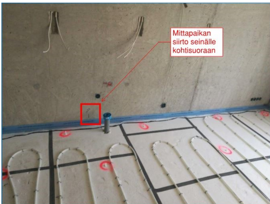
Kuva 18. Mittauspaikan siirto seinälle. Lukema(1422) osoittaa turvallisen mittausetäisyyden millimetreinä merkistä.
