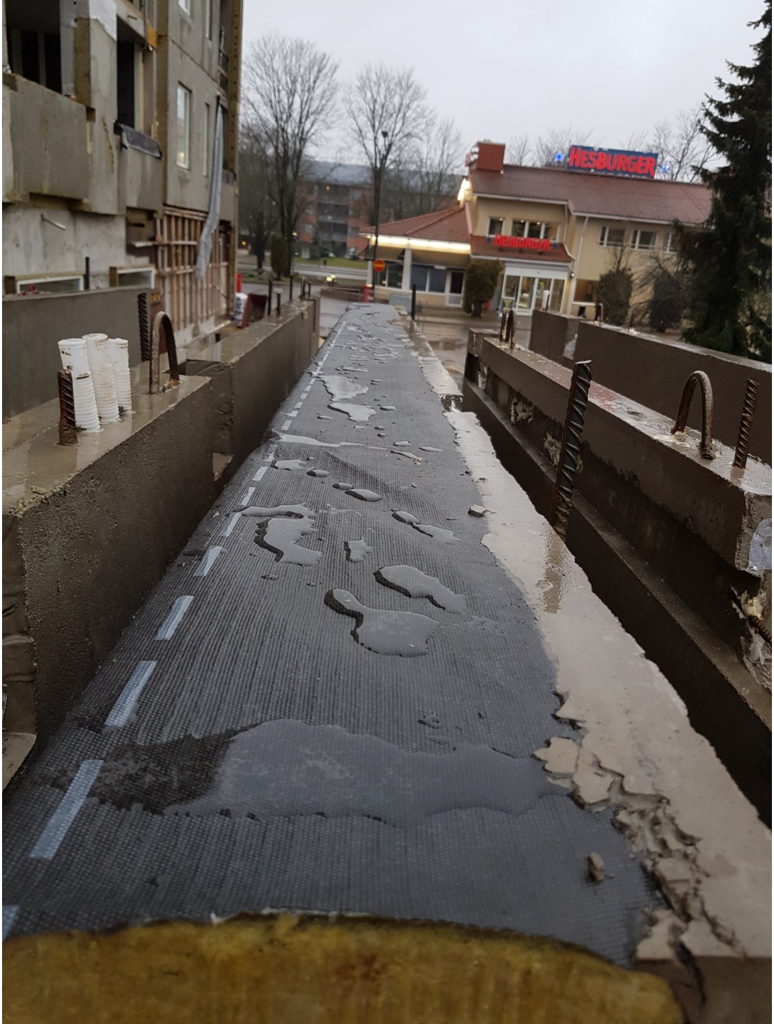
Kuva 3. Elementin villan yläosan suojaus.
