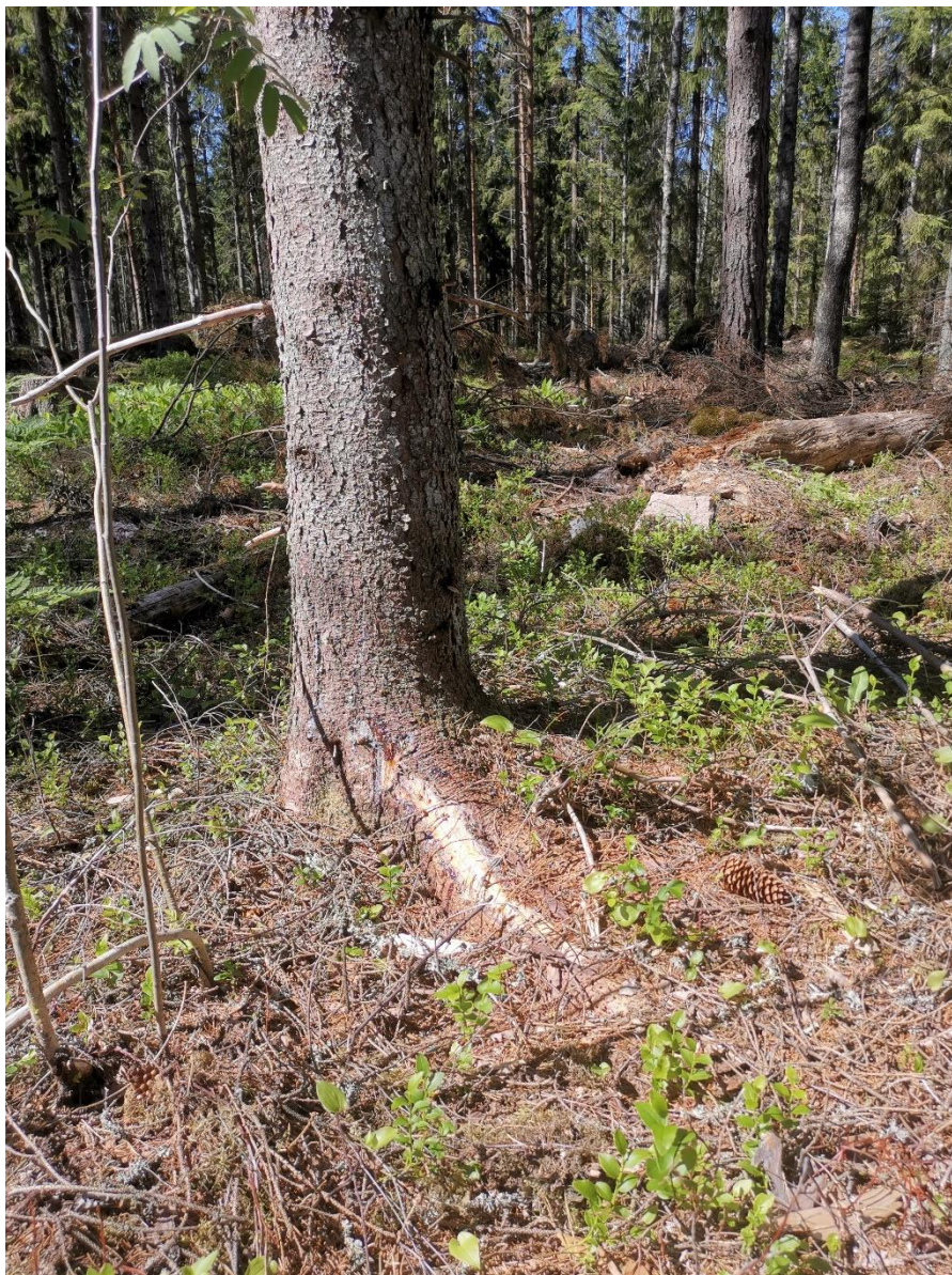
Bild 3. Rotskada som har förorsakats vid utkörning av virket (Foto: Kim Bergholm)
