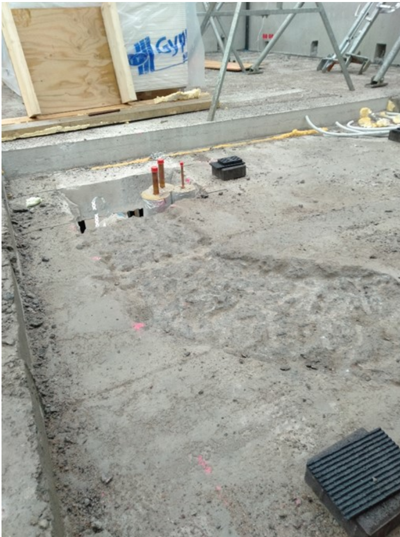
Kuva 4 Kylpyhuoneen asennuspalat asennettu oikeaan korkeusasemaan
