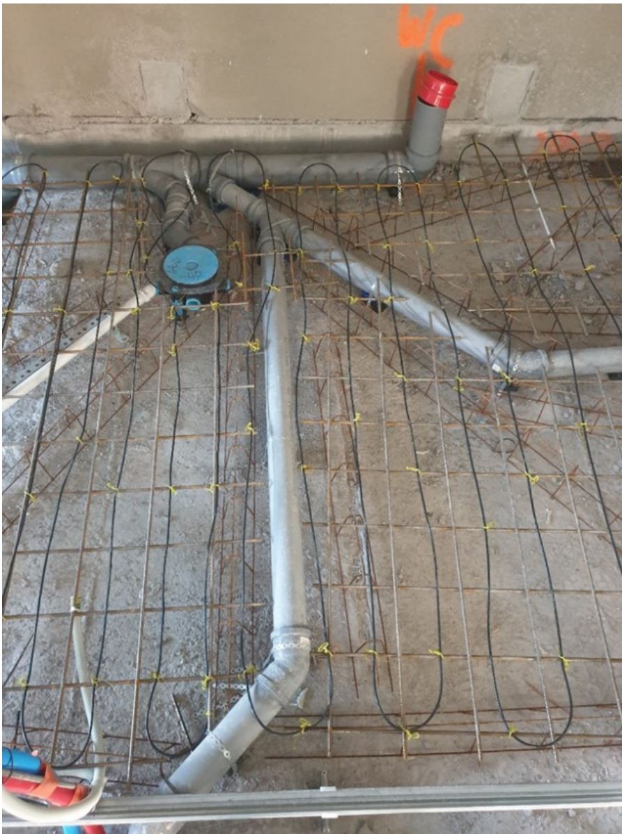
Kuva 6 Paikalla rakennetun kylpyhuoneen pintabetonilaatan valuvaihe valmistelut
