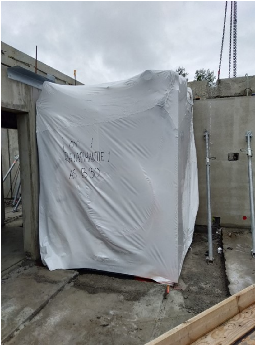
Kuva 5 Kylpyhuone-elementti asennettuna ja valuvalmistelu tukepellit asennettuna
