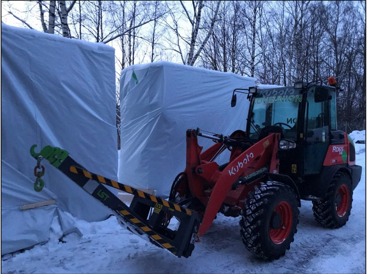
Kuva 13. Suojattuja ja varastoituja elementtinippuja
