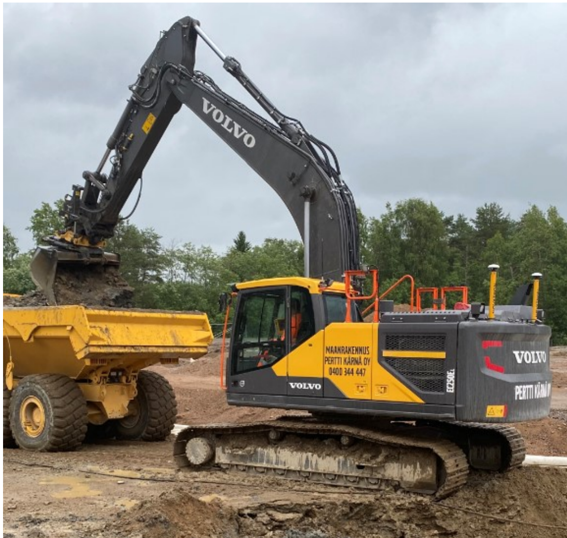
Kuva 6. Koneohjauksella varustettu kaivinkone Karstulan koulutyömaalla (Kärnä 2021)
