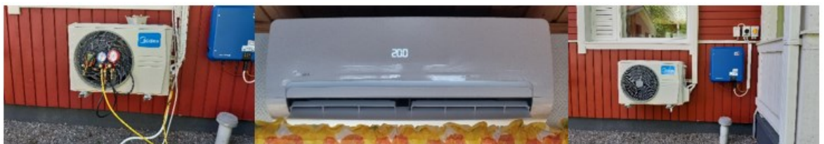
Kuva 14. Ilmalämpöpumpun asennus
