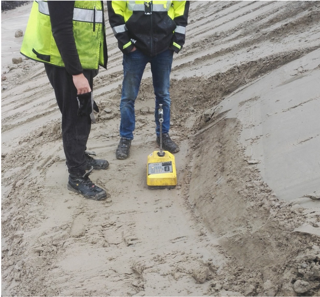
Kuva 7. Tiiveyden mittausta työmaalla Troxler-laitteella
