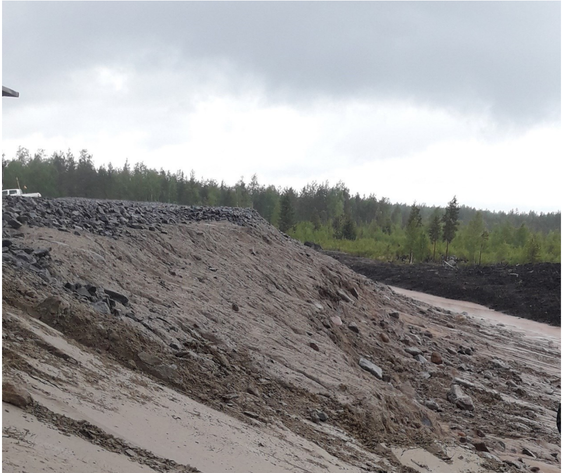
Kuva 8. Eroosion aiheuttamaan vauriota
