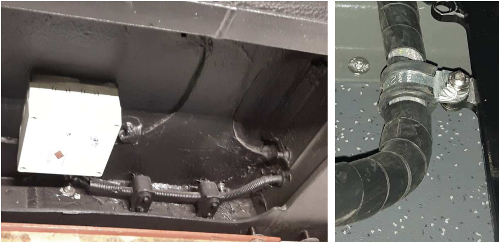
KUVA 16. Kaapeloinnin putkikiinnikkeitä alustassa ja johtosarjan kiinnitys asennussiteellä
