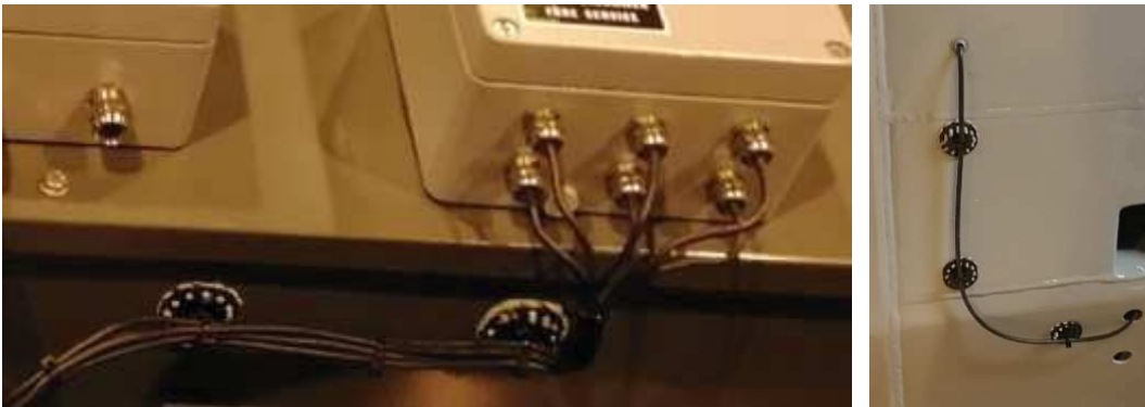
KUVA 18. Nippusideankkureita kaapeloinnin kiinnityksessä
