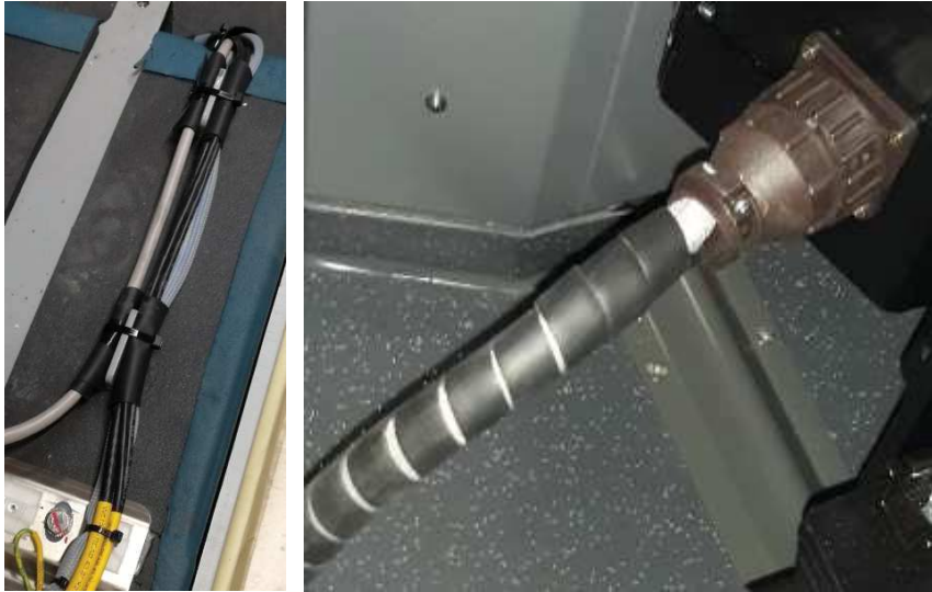
KUVA 20. Johtosarjojen suojaamista kumimatolla ja suojaspiraalilla
