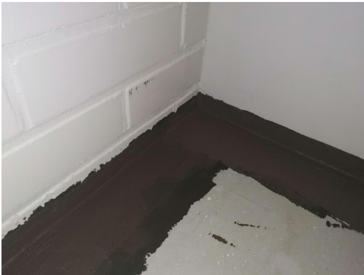
Kuva 7. Lattian ja seinän tiivistystyötä Ardex 8+9 vesieristeellä ja SK 12-vahvikenauhalla.
