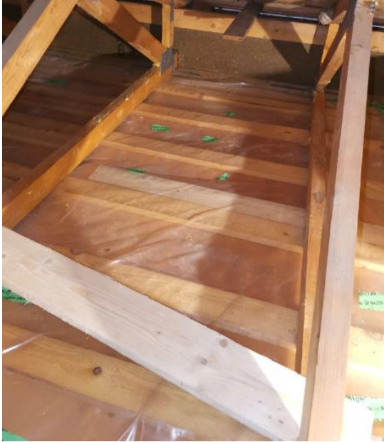
Kuva 6. Huoneiston yläpohjan höyrynsulkumuovin teippausta.
