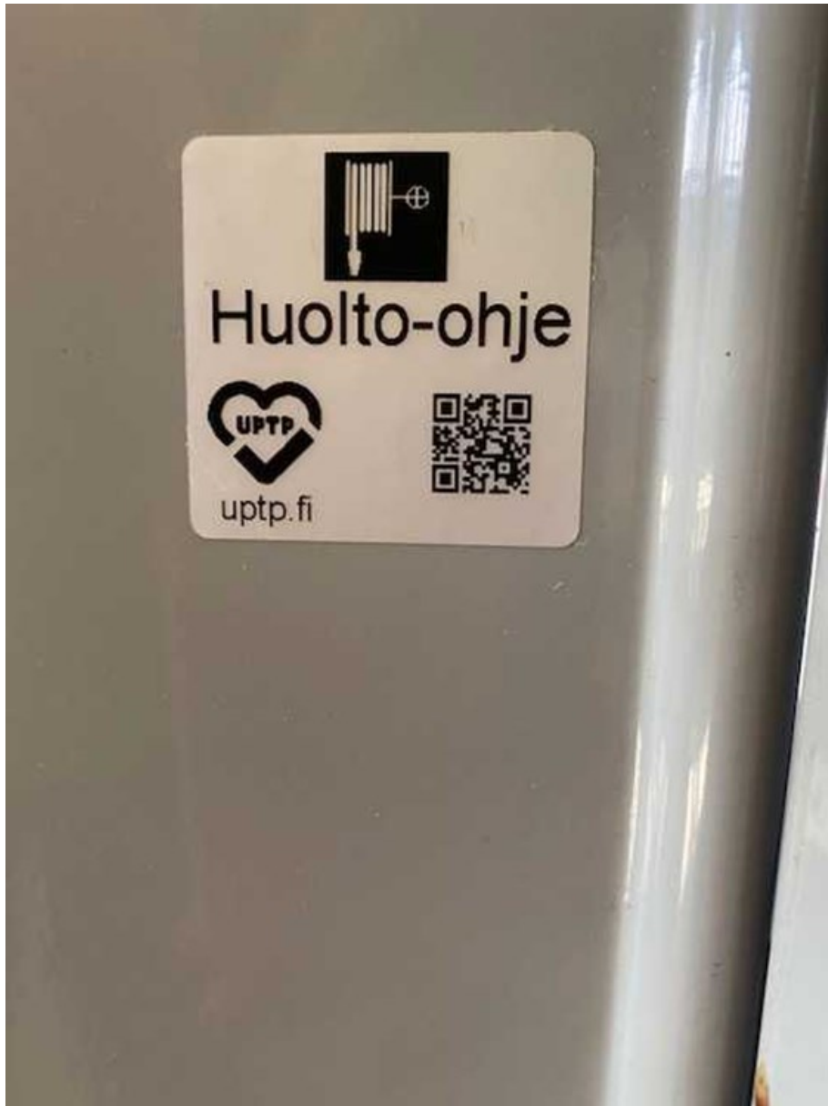
Kuva 8. Pikapalopostin huolto-ohje löytyy QR-koodin avulla.
