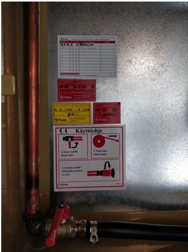
Kuva 2. Preston kurssilla tarkastettu pikapaloposti, jossa näkyvät selkeät käyttöohjeet [1].
