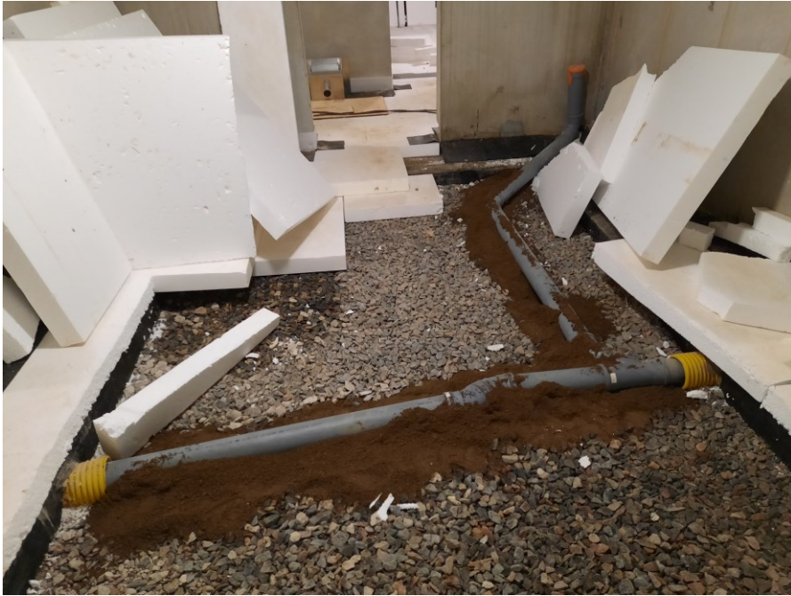
KUVA 5. Maanvaraisen alapohjan viemäroinnin tukeminen kivituhkalla
