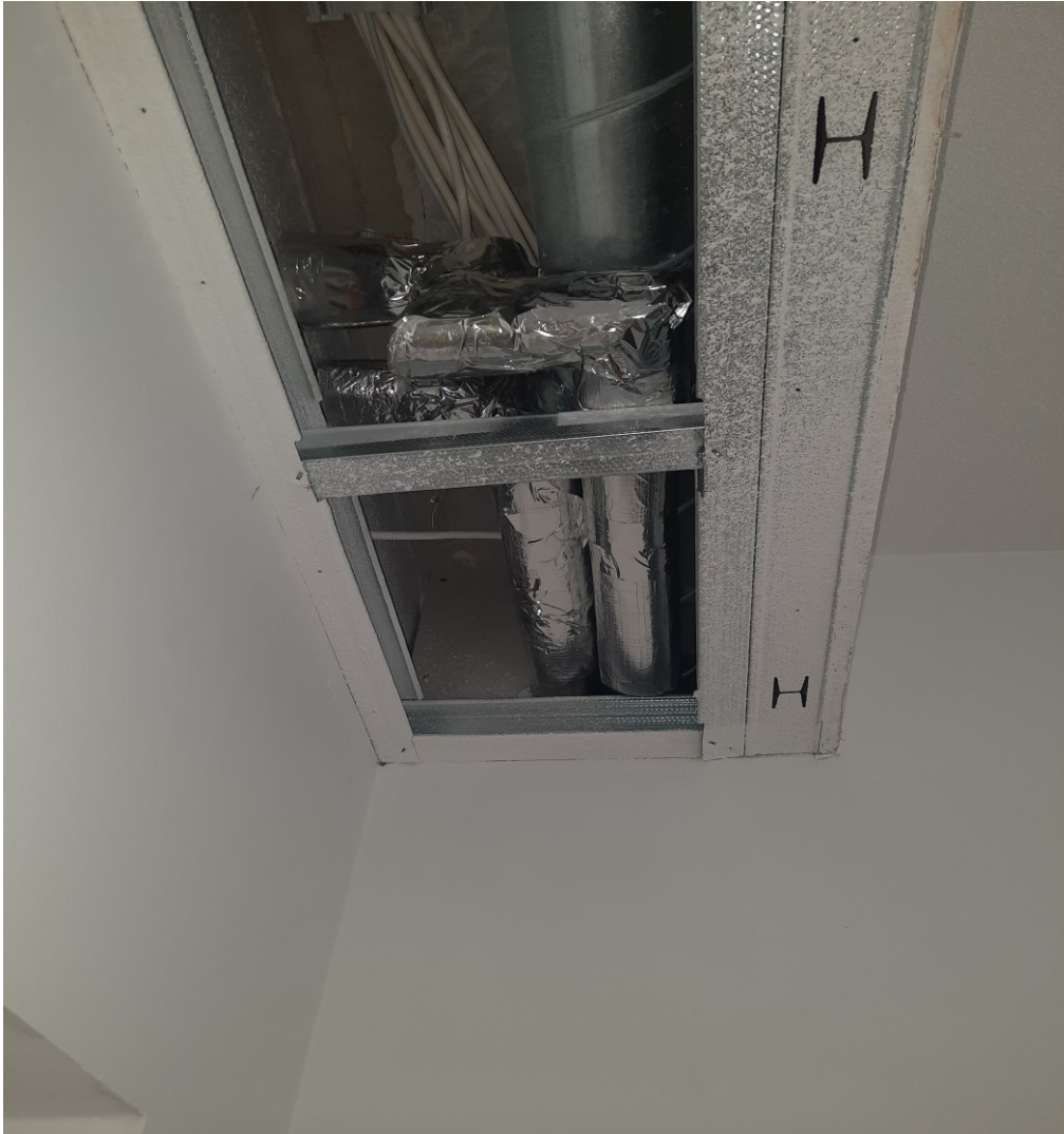
KUVA 14. Kivivillaputkieriste Sewatek-läpiviennin jälkeen
