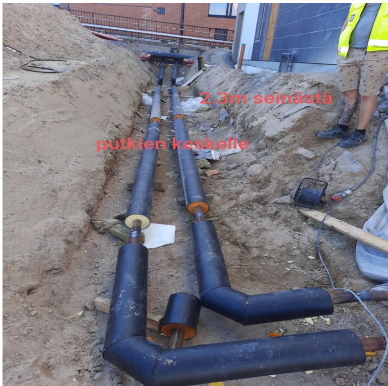
KUVA 7. Kaukolämpöputkiston asennus- ja dokumentaatio
