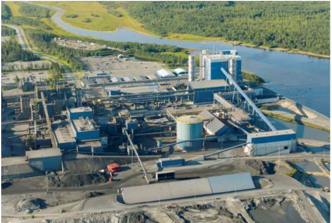
Kuva 2. Tornion ferrokromitehdas (Outokumpu 2021c)
