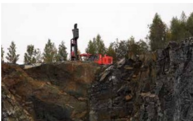
Kuva 1. Kallion poraus panostusta varten (Kalliosta murskeeksi)
