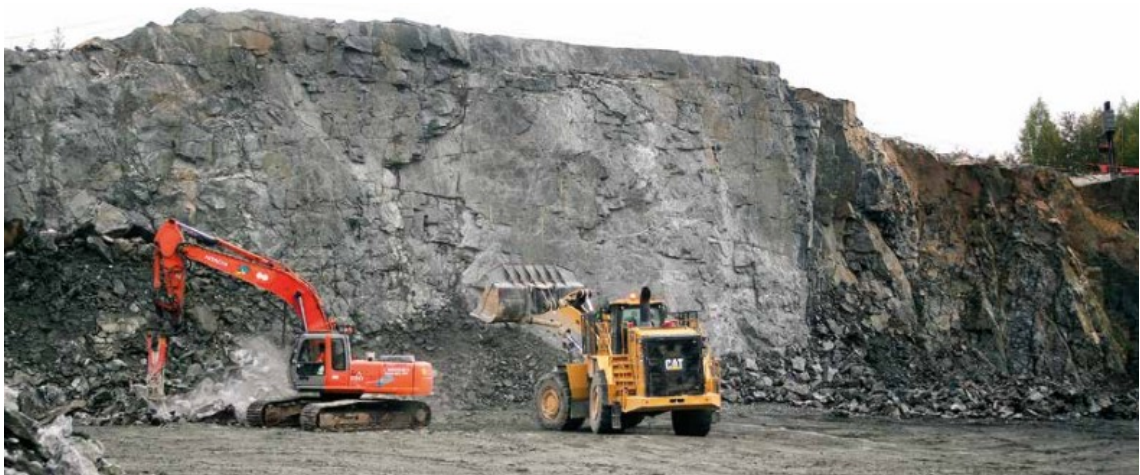
Kuva 2. Kivilouheen rammerointi (Kalliosta murskeeksi)
