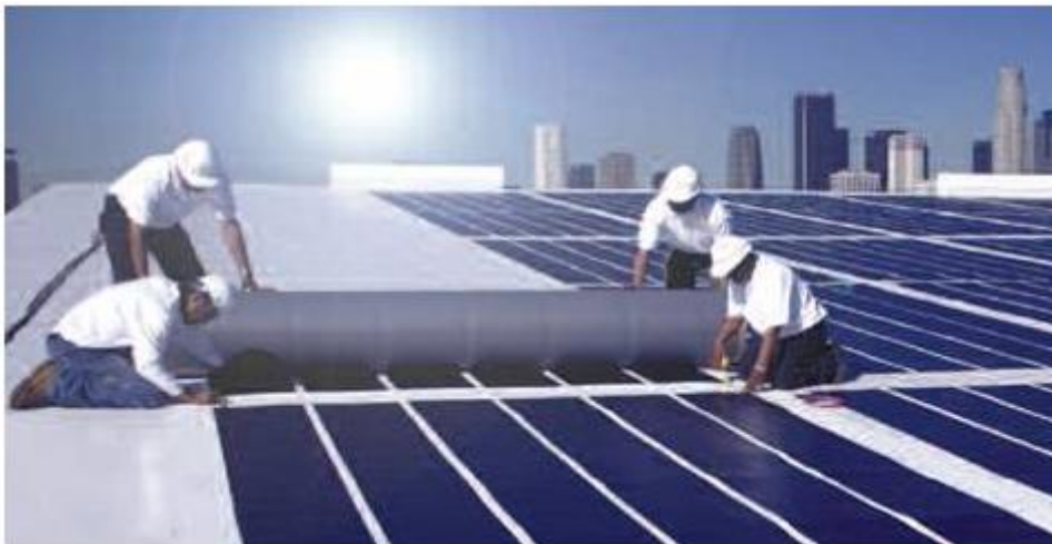
Kuva 6. Ohutkalvokennon asennusta (reuk)
