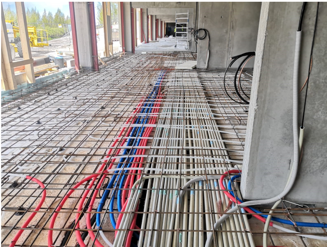
Kuva 1. Yrityksen hallityömaalta otettu kuva putkituksista.
