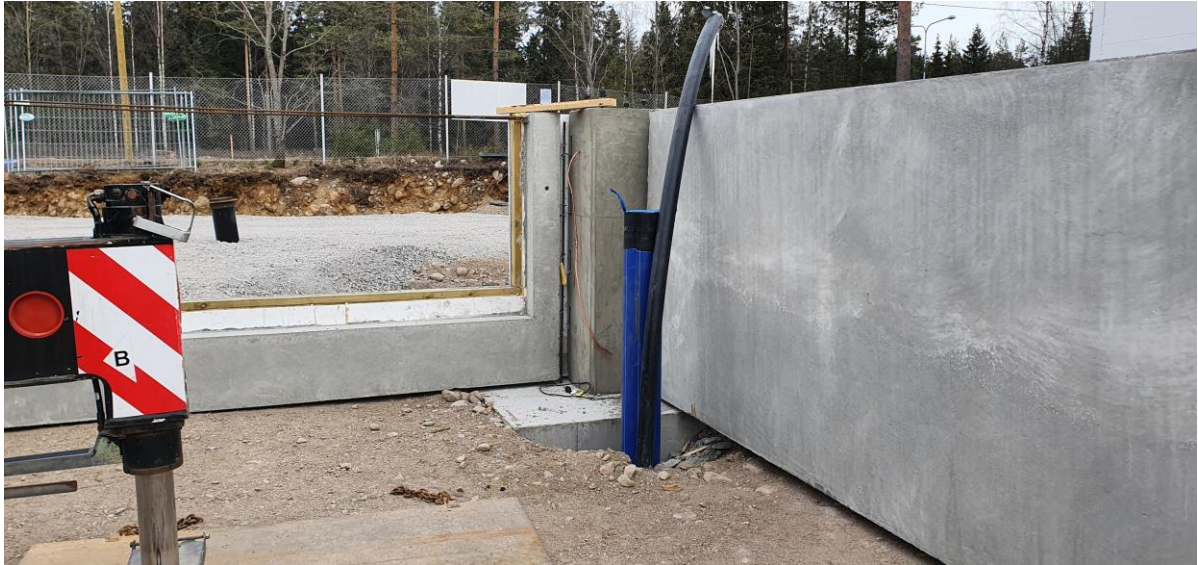
Kuva 3 Edellisessä kuvassa esitetty pilari valettuna sekä sokkeli asennettuna
