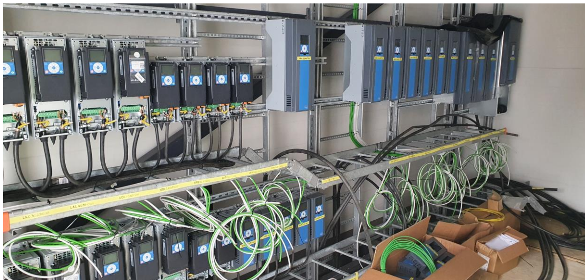
Kuva 8 Biohöyrylaitoksen taajuusmuuttajia asennuksessa – syksy 2020
