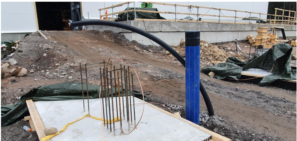
Kuva 2 Anturan raudoitukselle nouseva maadoitusjohdin sekä laitokselle tulevat syöttövesiputket
