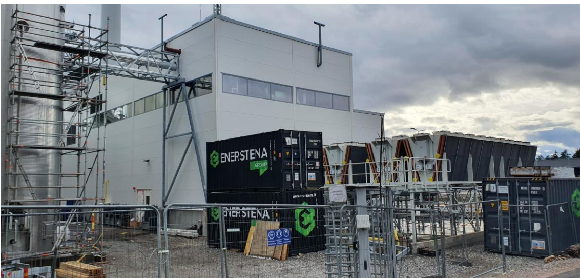
Kuva 5 Lämpölaitos kuvattuna pohjoiselta sivulta huhtikuussa 2021
