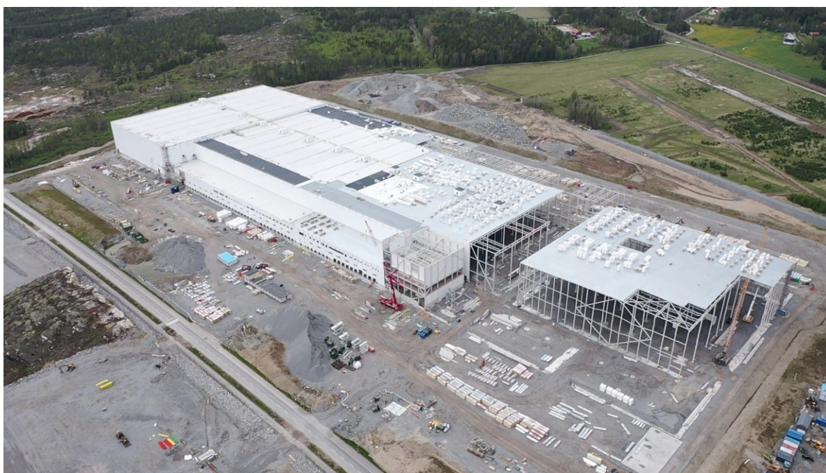
Figur 1. Byggprojektet, byggnaden börjar småningom få sin slutliga form.
