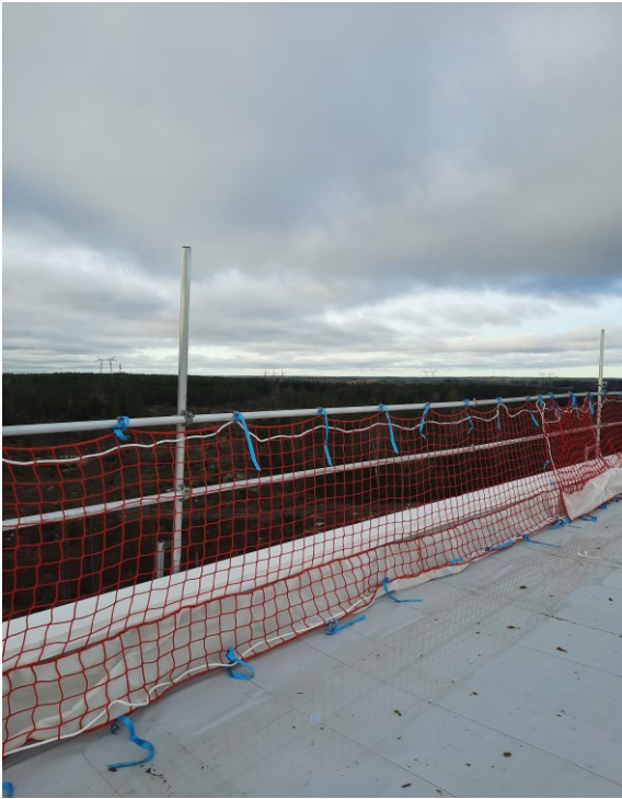
Figur 10. Skyddsräcke, fäst i utsidan av stommen.
