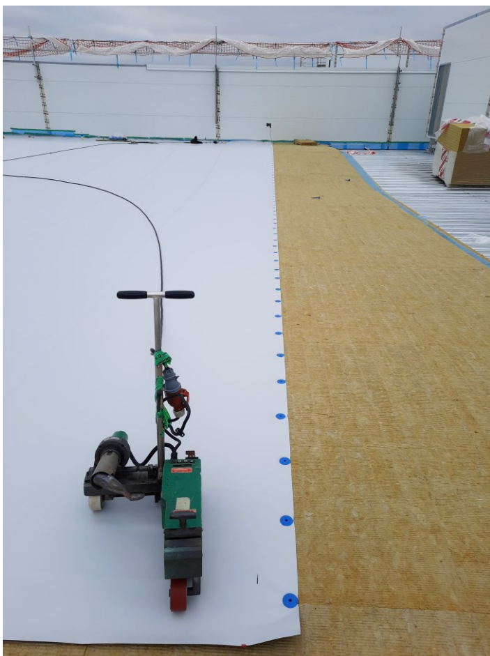
Figur 8. Svetsmaskinen som används vid sammanfogning av skarvar.
