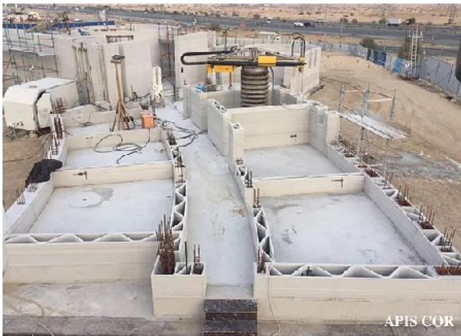
Kuvio 13. Havainnekuva rakennustyömaalta (Apis Cor 2021)
