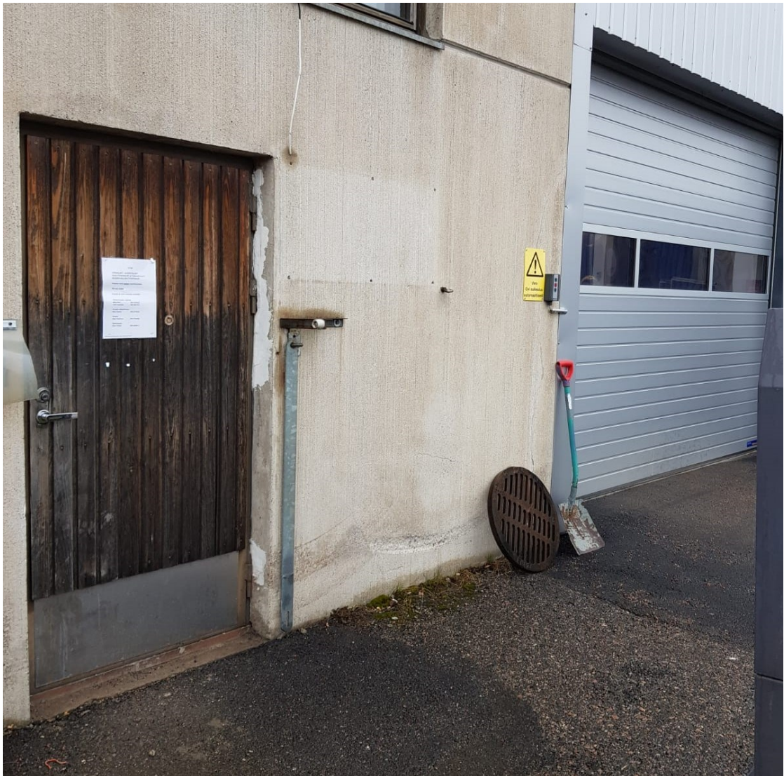
Kuva 1. Nurmijärven toimipiste, sisäänkäynti sähkölaittekorjaamon tiloihin.
