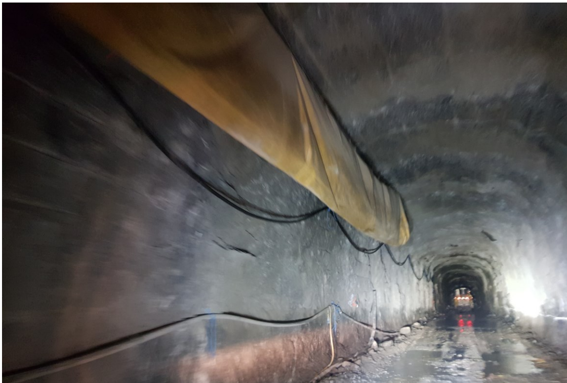
Kuva 10. Sulkavuoren jätevesipuhdistamo Tampereella, VYK-syöttökaapelin ripustus.
