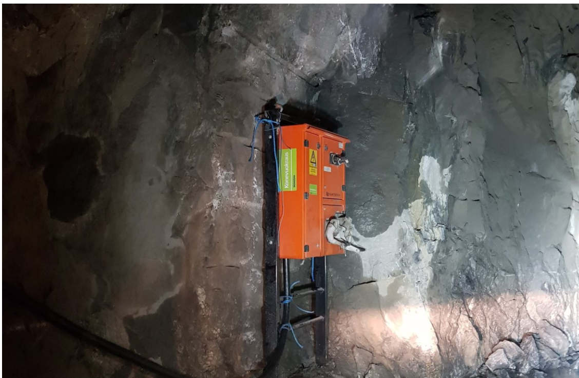
Kuva 9. Tunnelityömailla käytettävä VYK.
