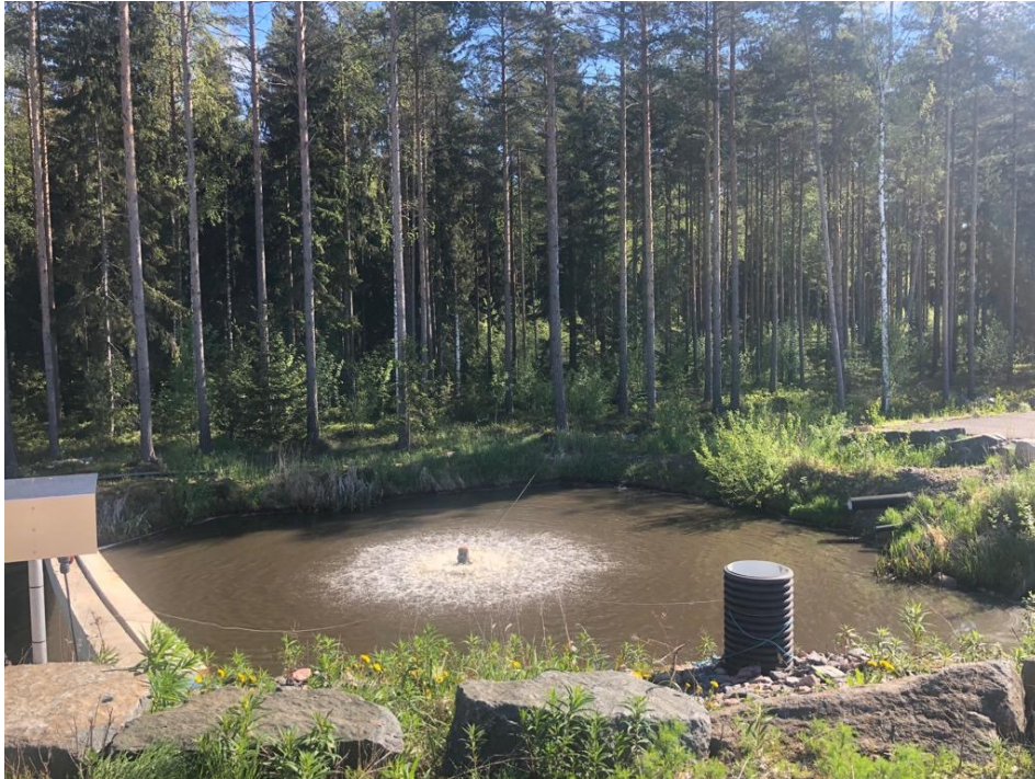
Kuva 1. Kompostointilaitoksen tasausallas ja ilmastin. (©LSPV Oy, Antti Rantanen).
