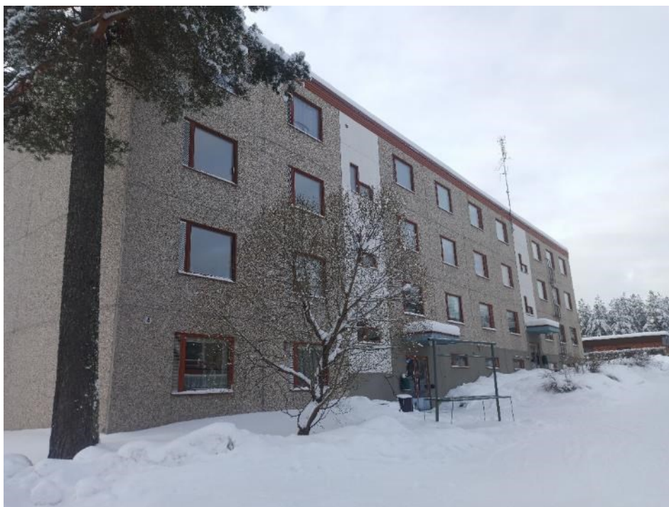
KUVA 7. Leivontie 4 pääjulkisivu (Pirinen 2021, CC BY-NC-ND)
