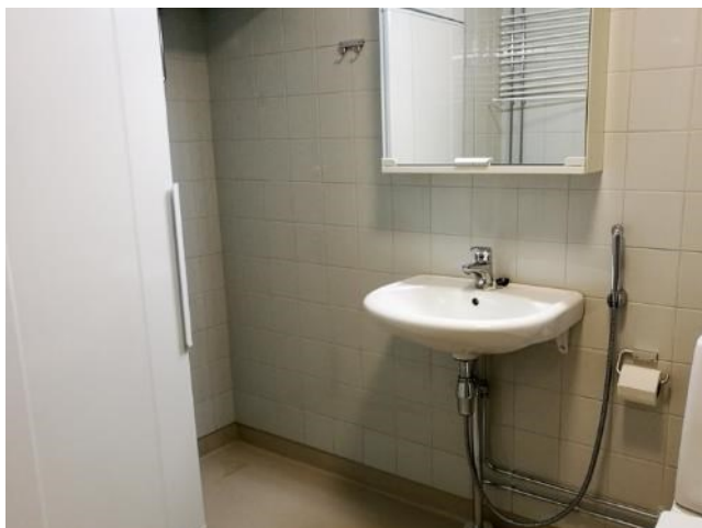
KUVA 100. Nykyiset kylpyhuoneet. Tyhjässä nurkassa paikka pyykkikoneelle ja kuivauskaapista näkyvissä vedin (Niiralan Kulma)
