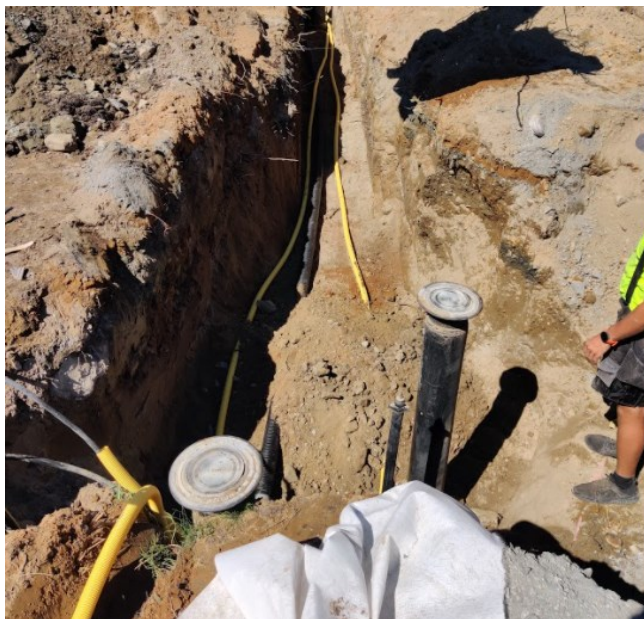
Kuva 5. Kaivanto liittymäkaapelille sekä vesi- ja viemäriputkille.
