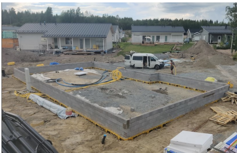
Kuva 6. ennen sisätäyttöä asennettiin suojaputket.
