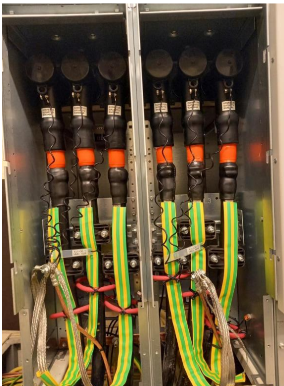
KUVA 3. Kosketussuojatut kulmapistokepäätteet
