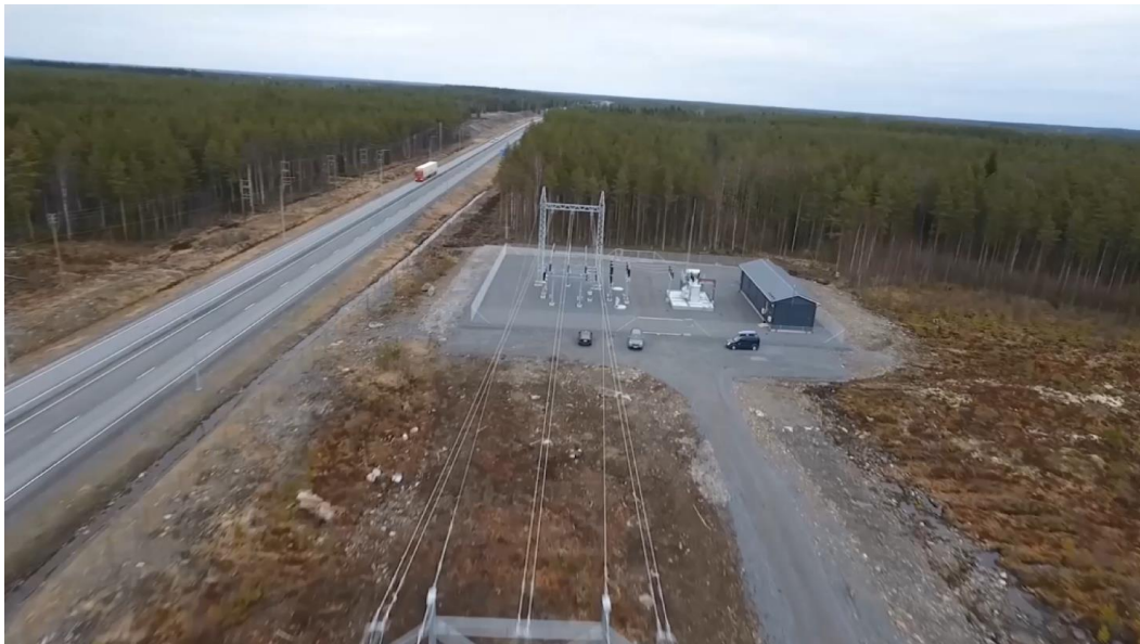
Kuva 12. Ilmakuva Kärmeskydön sähköasemasta.
