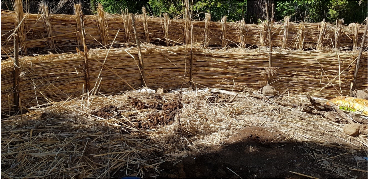
Kuva 13. Ruokopenkereen kuva rakentamisen aikoihin kesällä 2020.
