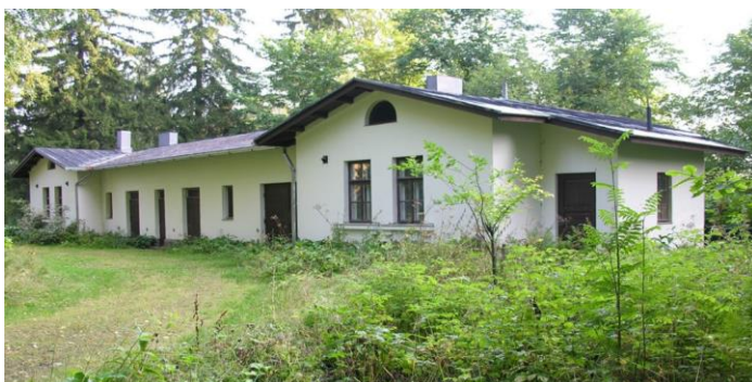
Kuva 5. Kanalarakennuksen etupuoli. (Kuva: Heimo Siivonen, aikanaan.fi/pitkäniemi)
