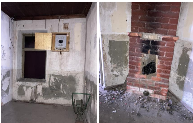
Kuvat 17 ja 18. Kohteen pohjoispäädystä sijaitsevat tilat. (pohjakuvassa Huone 1).
