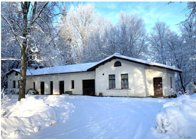
Kuva 7. Kanalarakennuksen etupuoli vuonna 2021.
