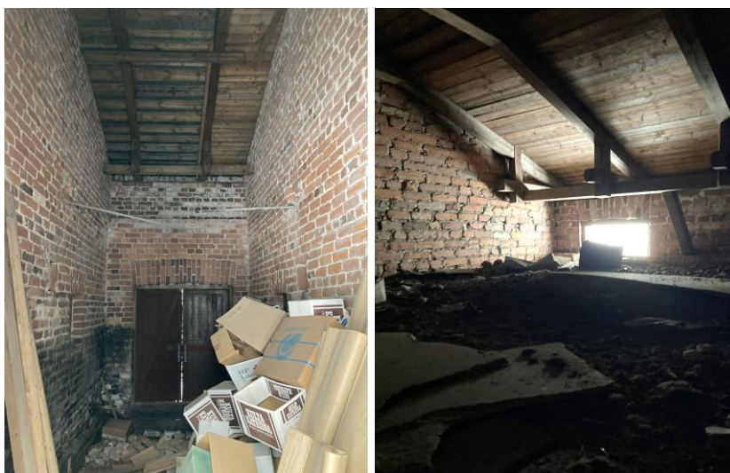
Kuva 15 ja 16. Vasemmalla vanha lantala, noin 5-7 metrin huonekorkeudella. Oikealla puolen kuvattuna väli- ja yläpohjan välinen tila.
