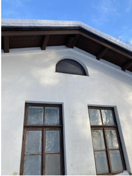
Kuva 21. Yläpohjan puolipyöreä tuuletusikkuna.
