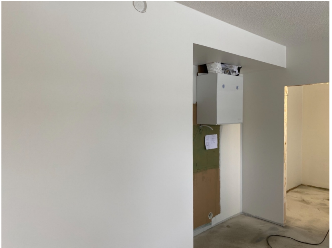
Kuva 12. Seinäpintojen maalaustyöt valmiit
