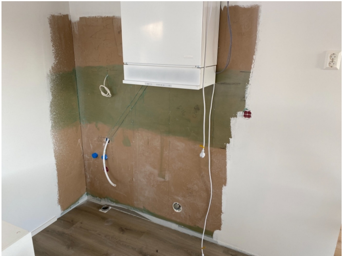
Kuva 14. Kosteussulku asennettu keittiön välitilan kohdalle
