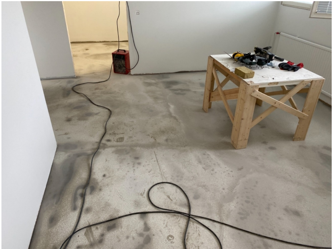
Kuva 11. Lattioiden tasoitustyöt valmiit
