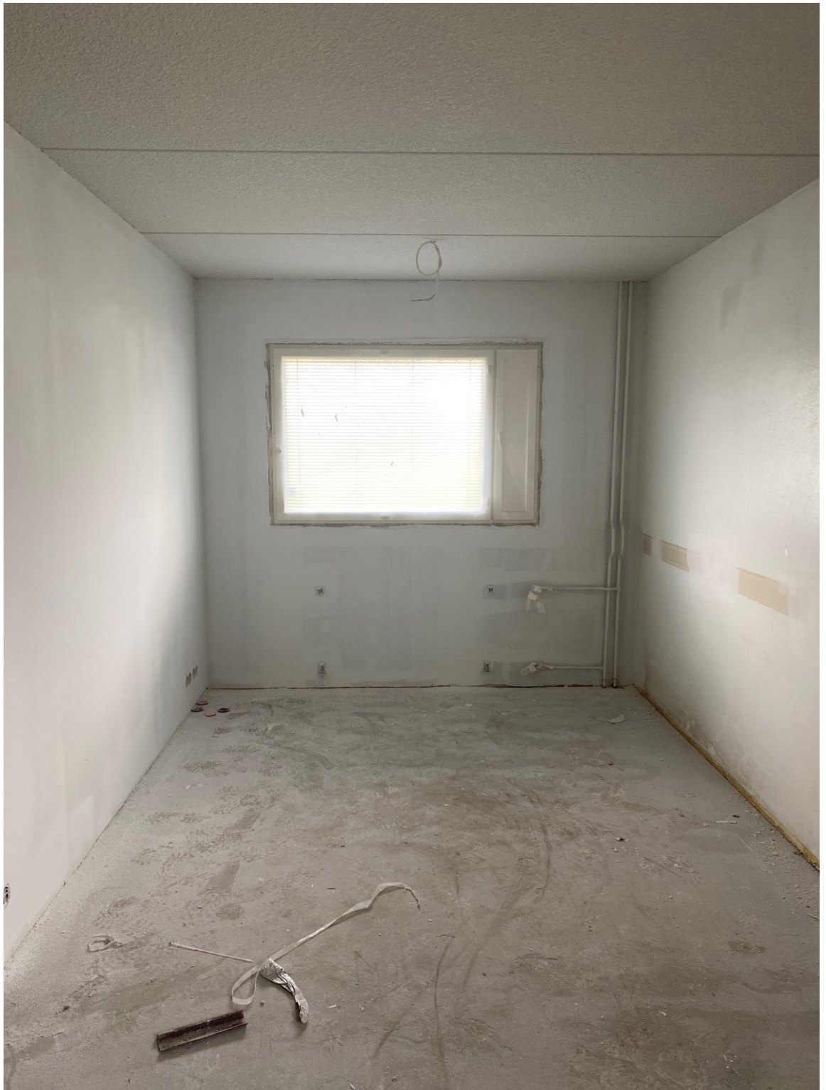
Kuva 9. Seinien tasoituksia ja pohjamaalauksia tehtynä
