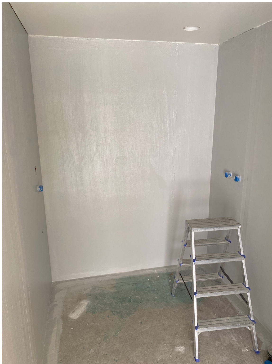
Kuva 7. Vedeneristys asennettu seinin
