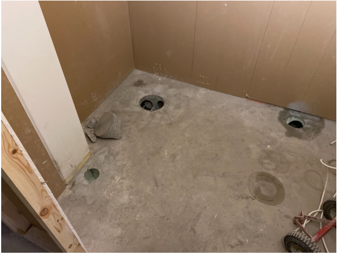
Kuva 4. Lattiakaivon ja viemärin läpivienti
