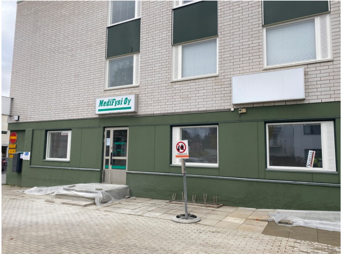
Kuva 17. Muutostyön osilta julkisivu tehtiin vastaamaan muuta julkisivua
