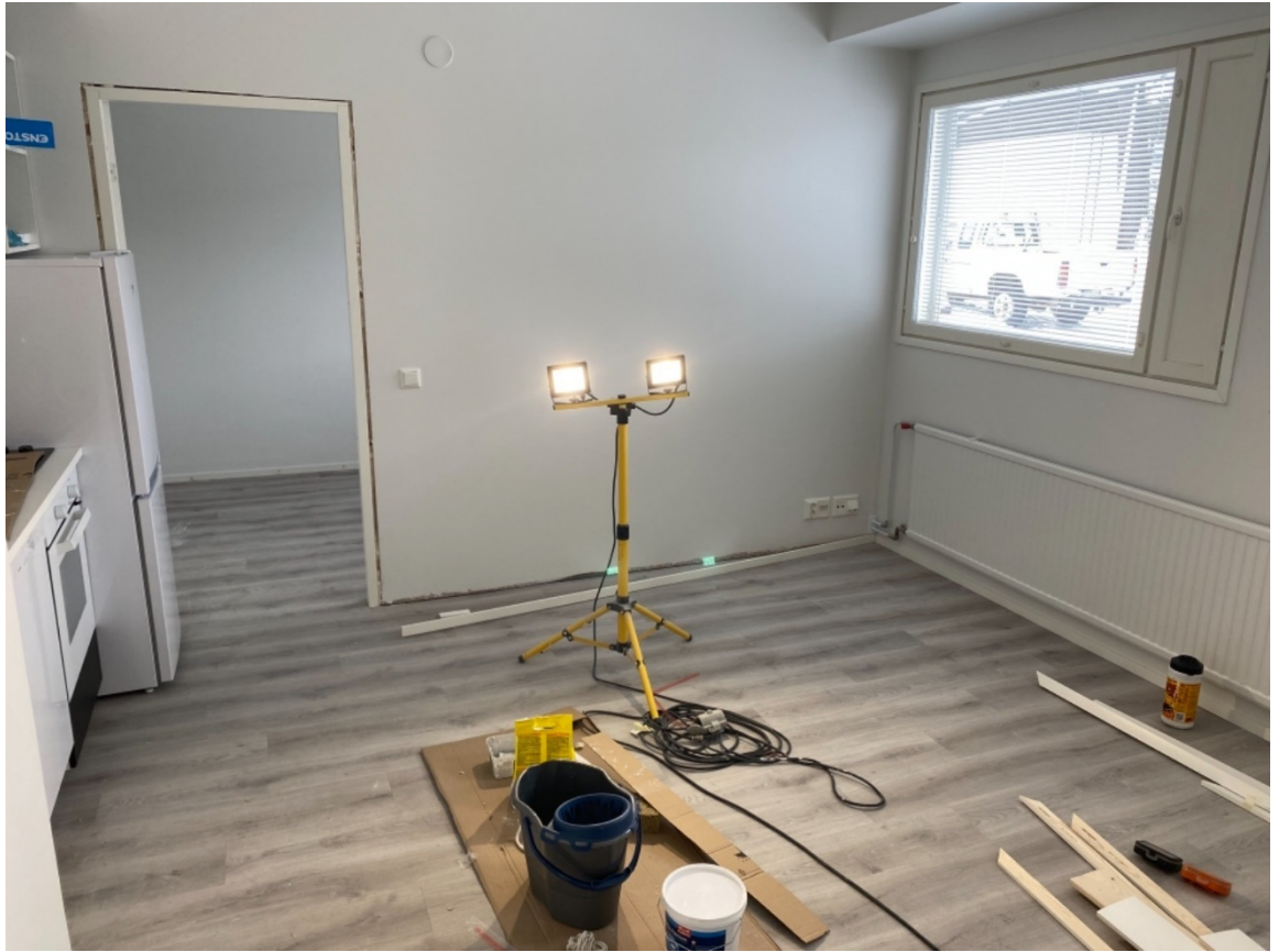
Kuva 13. Lattipinnoitteet asennettuna ja listoitustyöt aloitettu
