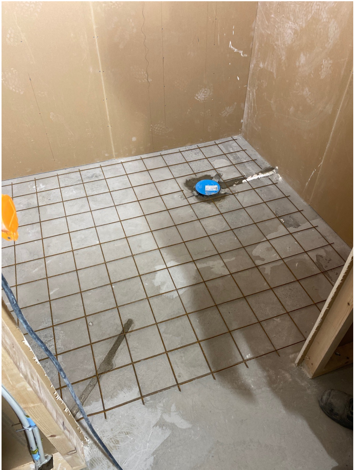
Kuva 6. Betoniverkko valmiiksi leikattuna lattiavalua varten
