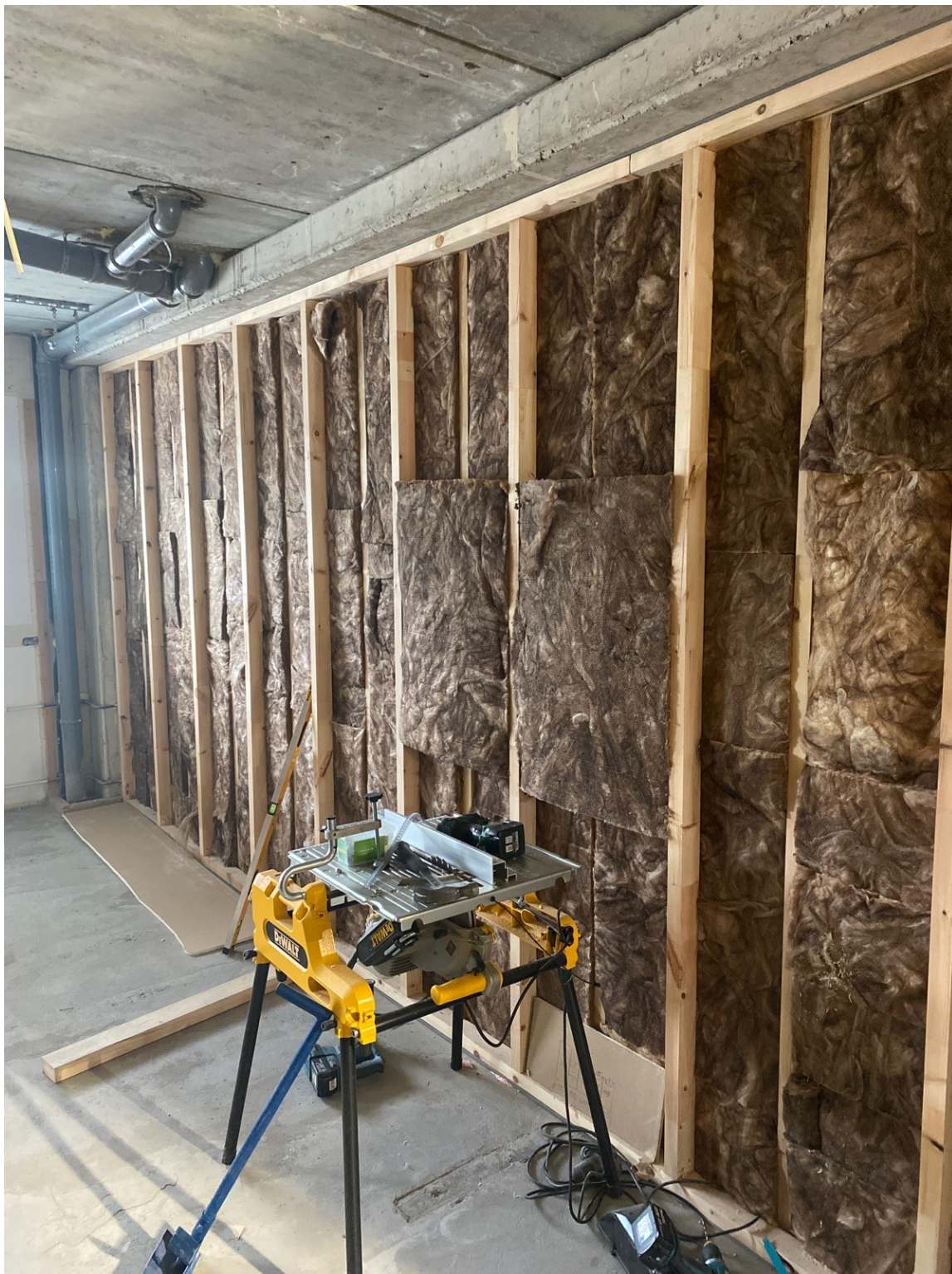
Kuva 2. Eristetty huoneistojen välinen väliseinä
