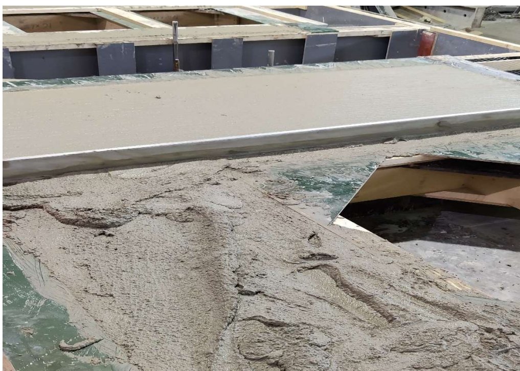
Kuva 7. Pohjarappauksen tekeminen tehdasolosuhteissa (Karhunen 2021).
