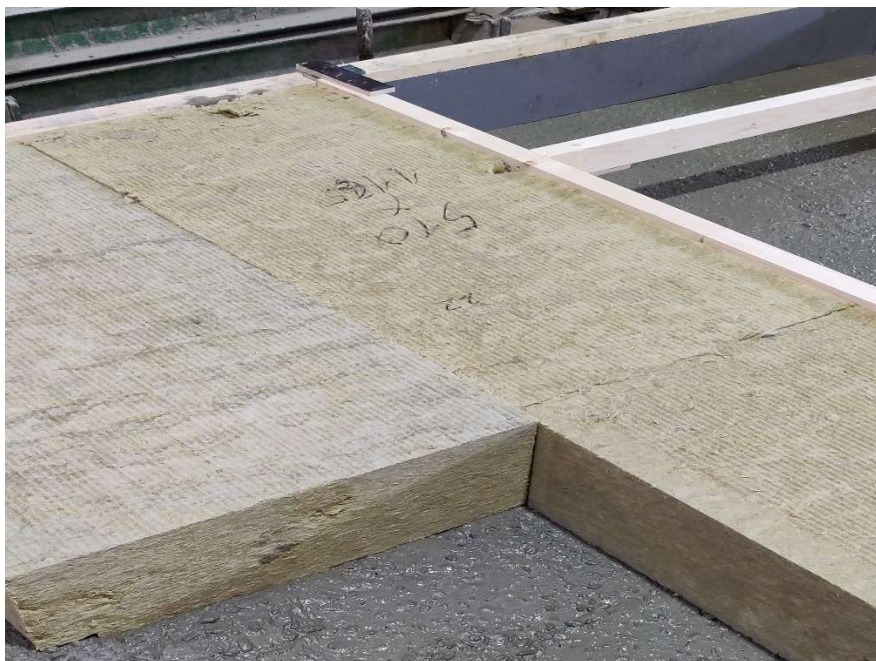
Kuva 2. Lämmöneristeiden asentaminen vasta valetun sisäkuoren päälle (Karhunen 2021).
