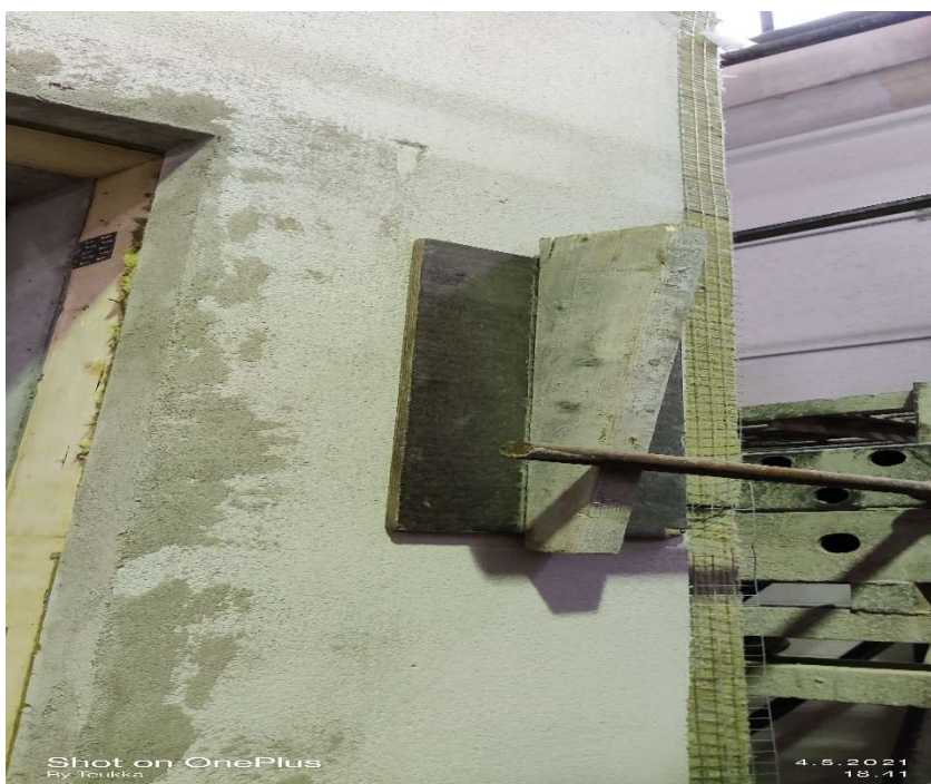
Kuva 8. Rappauksen puolelle asennettu kiila + vanerilevy jakamaan pistekuormaa (Karhunen 2021).
