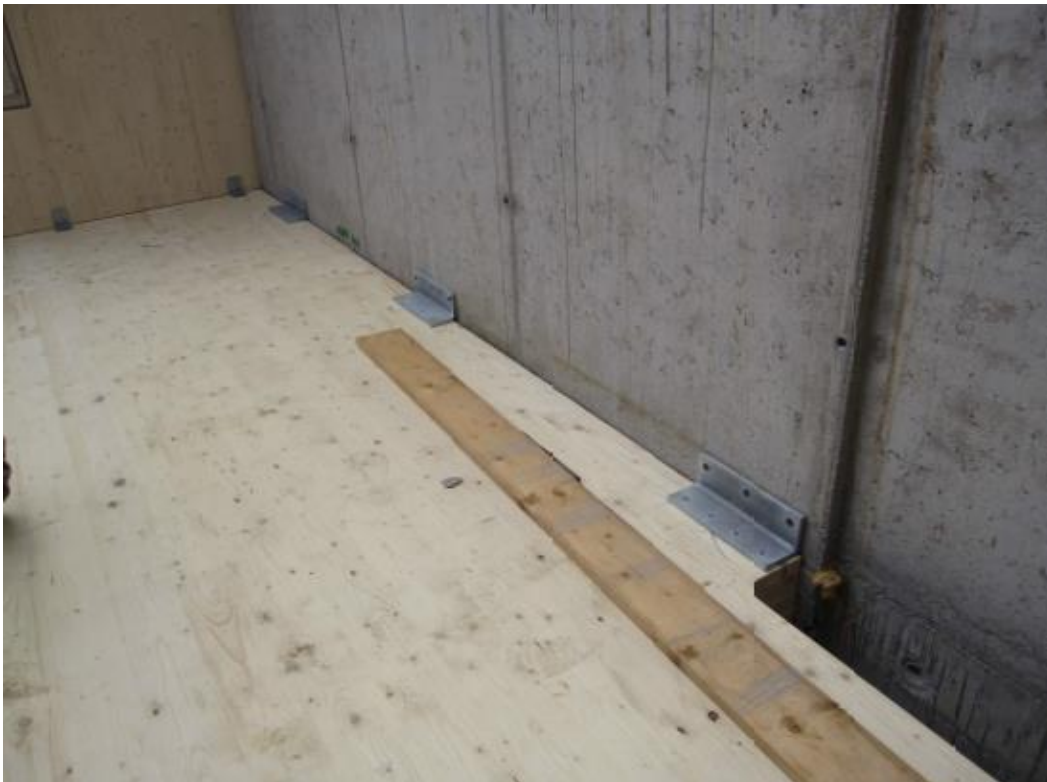
Kuva 13. CLT-välipohjan liitos jäykistävään rakenteeseen (Lahtela 2020)
