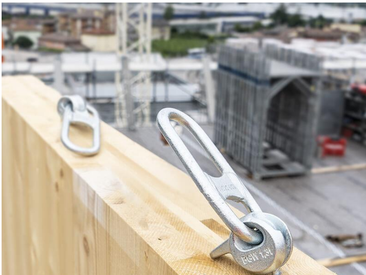
Kuva 16. Nostolenkin kiinnitys elementtiin (Rothoblaas 2021c)
