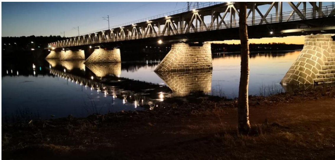
KUVA 1. Ounaskosken silta (Destia Group 2019)
