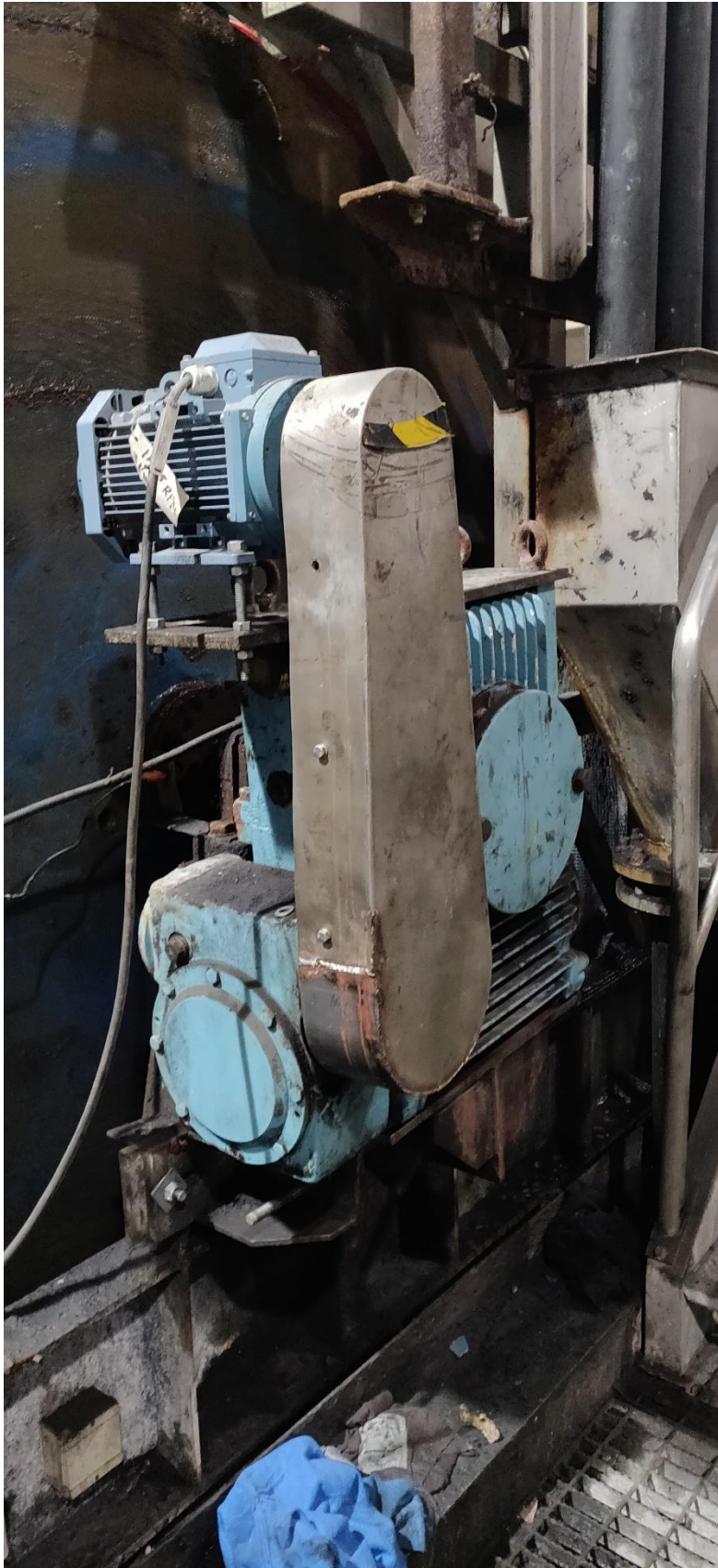
Kuvio 18. Suotimen 4110 käyttö. Sähkömoottori ja vaihdelaatikko.
