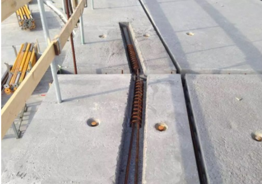
Kuva 8. Superlaatan pituussuuntainen sideraudoitus. (17)
