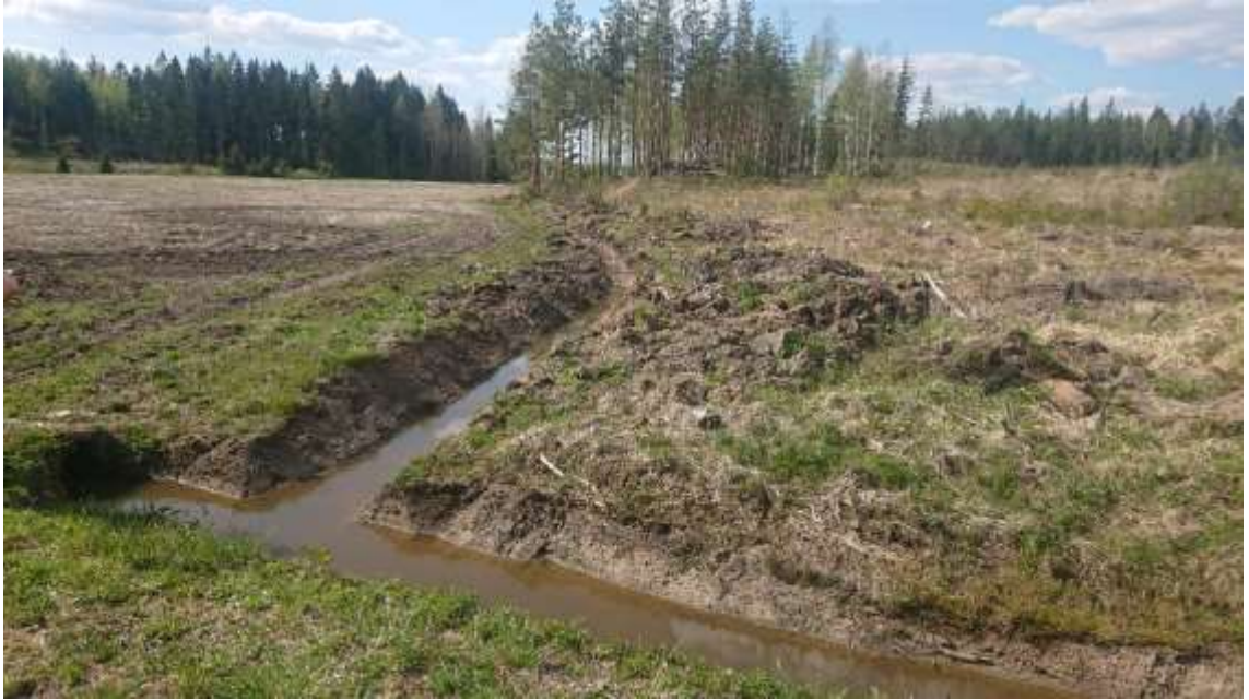
Kuva 21. Ojia kunnostettaessa ei suositella teräviä kulmia. Kuvassa näkyvään ojien risteykseen olisi helppo tehdä laskeutusallas. Kuva: Juuso Kosonen.
