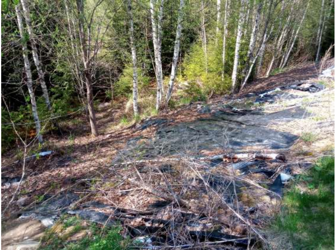
Kuva 25. Luultavimmin kaatopaikan pintavalunnan ohjaukseen tarkoitettu muovitus on osin vaurioitunut ja irronnut paikaltaan. Kuva: Juuso Kosonen.
