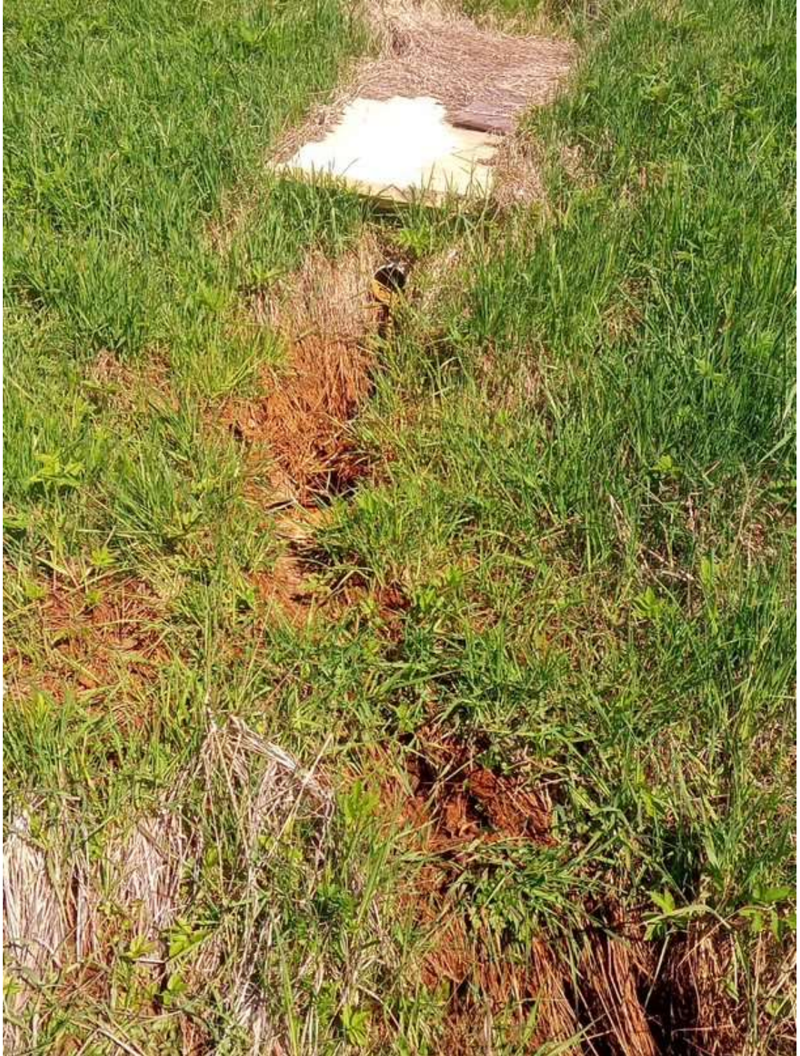
Kuva 30 Pohjavesi pumppaamosta poistettava rautasakka on värjänyt poistoputken punaiseksi. Kuva: Juuso Kosonen.
