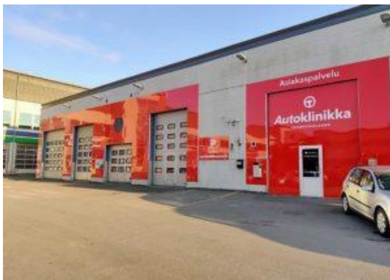
KUVA 2. Autoklinikka Tampere (Autoklinikka-Yhtiöt Oy)
