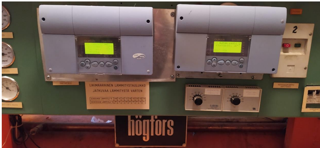
Kuva 9. Säätokeskukset
