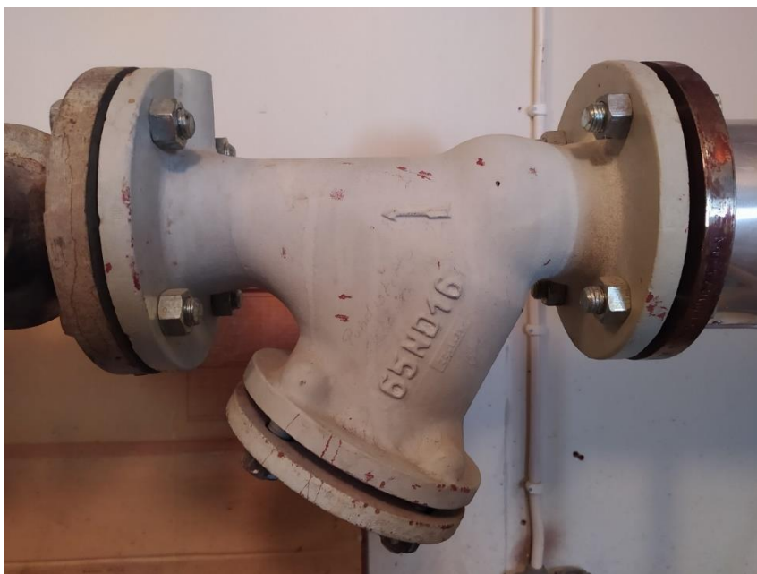
Kuva 10. Mudanerotin kaukolämpölinjassa
