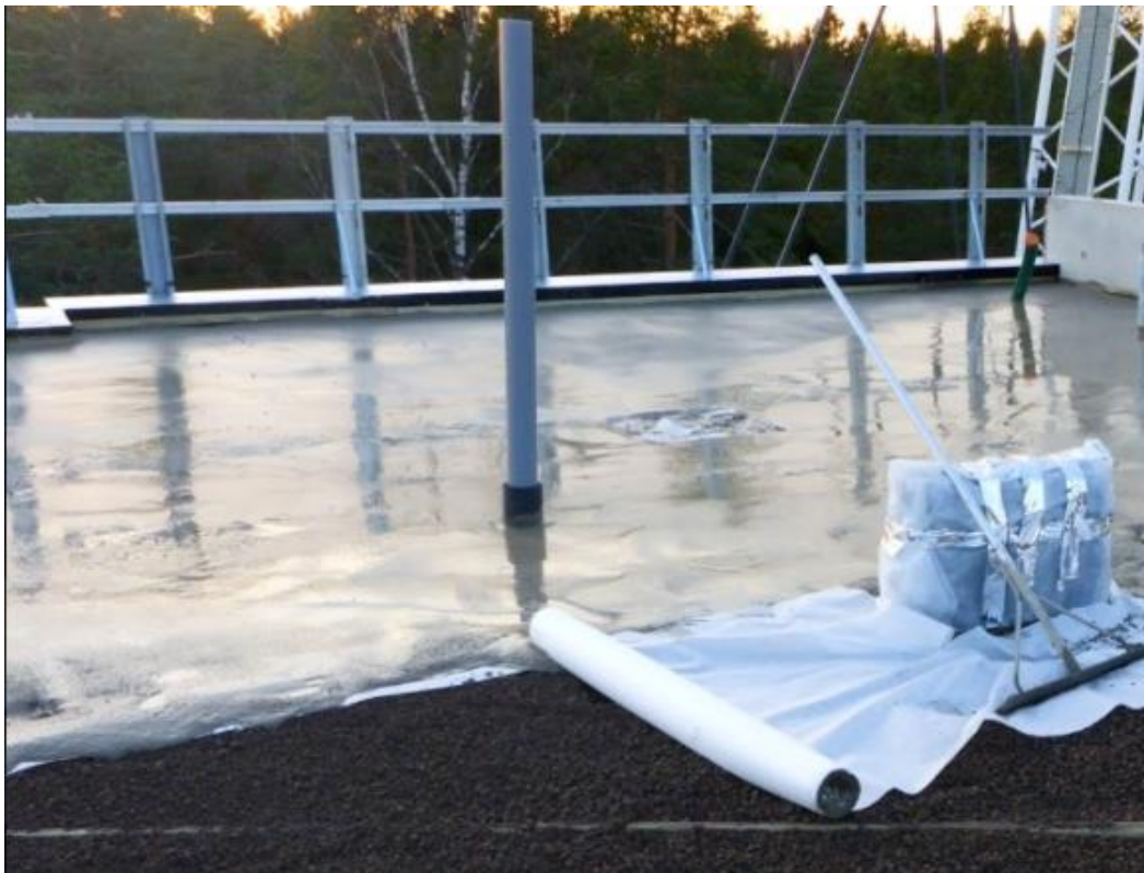
Kuva 12 Vesikaton hiertobetoninen pintavalu (Salminen, 2020)
