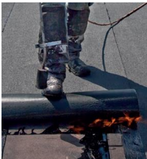
Kuva 6 Pintakermin asennus. (Toimivat katot 2019)
