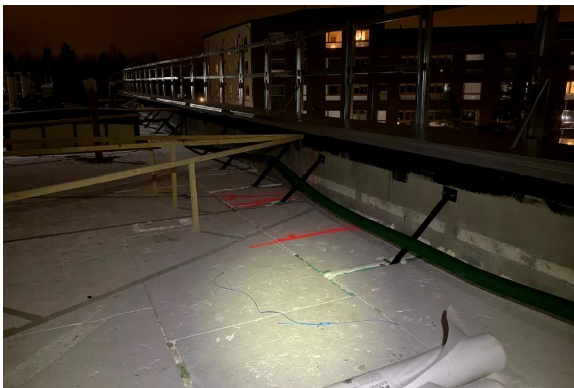
Kuva 10 Asennettu lisäeristekerros As.oy Helsingin Kuninkaankilvessä (Salmi- nen, 2020)
