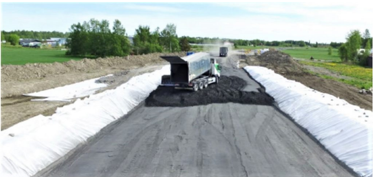
KUVA 1. Tuhkakuljetuksen purku rakenteilla olevaan pengerrakenteeseen vt3/Vt8 [6]
