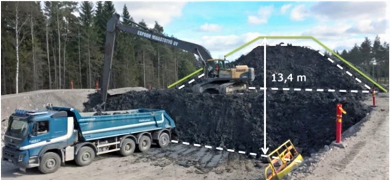
KUVA 2. Kehä 1 Sepänmäki. Stabiloidusta sedimentistä rakennettu meluvalli [6]
