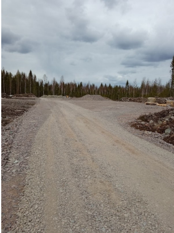
Kuva 15. Tuulivoimala A:n nostoalue Hankilan tuulipuistossa
