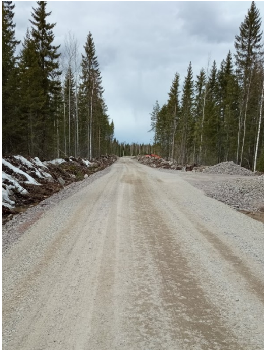
Kuva 13. Hankilan tuulipuiston kunnostettu metsäautotie
