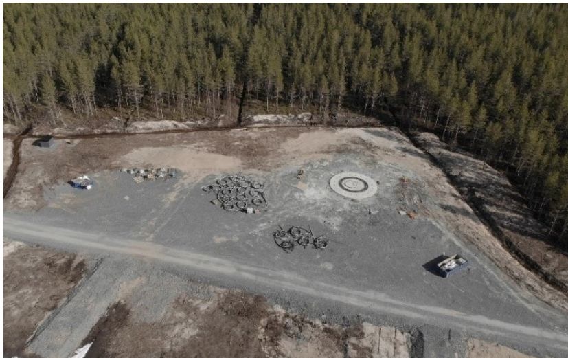
Kuva 18. Parhan tuulipuiston tuulivoimalan nostoalue (Mikko Piipponen, Suomen Maastorakentajat Oy 2021)
