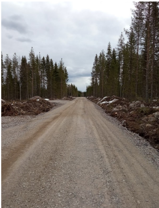
Kuva 14. Hankilan tuulipuiston kunnostettu metsäautotie
