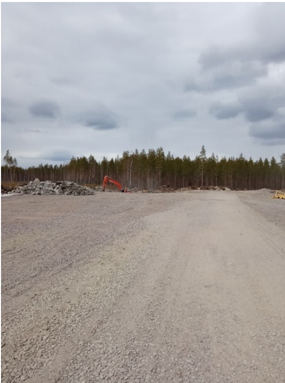
Kuva 16. Tuulivoimala B:n nostoalue Hankilan tuulipuistossa
