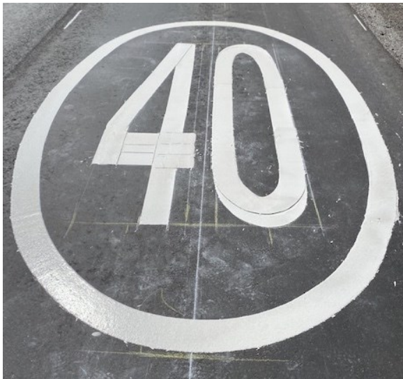
Kuva 6 : Esimerkki muusta tiemerkinästä työmaalla
