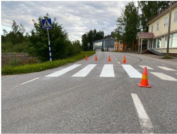
Kuva 5 : Esimerkki poikittaissuuntaisesta merkinnästä työmaalla
