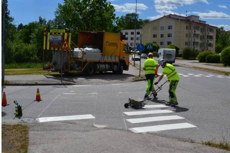
Kuva 2: Pienmerkintätyötä työmaalla (Ratala 2018).
