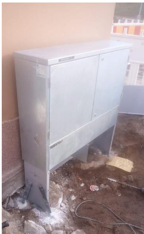
Kuva 8. Kabeldon SDC 1098 kalliokiinnitys (Tatu Kinnunen, 2020)
