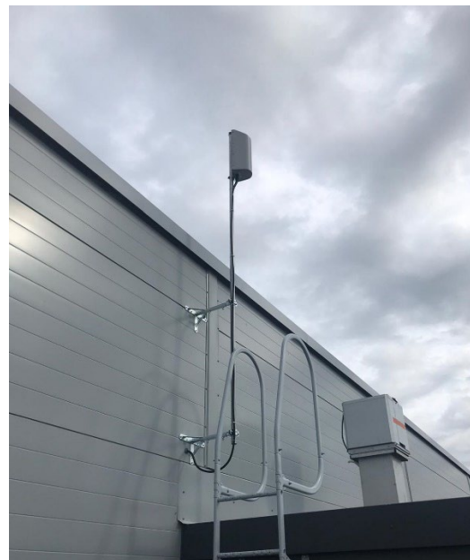
Kuva 1. Virve-toistimen ulkoantenni mastoon asennettuna
