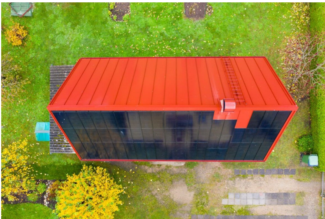
Kuva 13. 7 kW aurinkokattototeutus [18].
