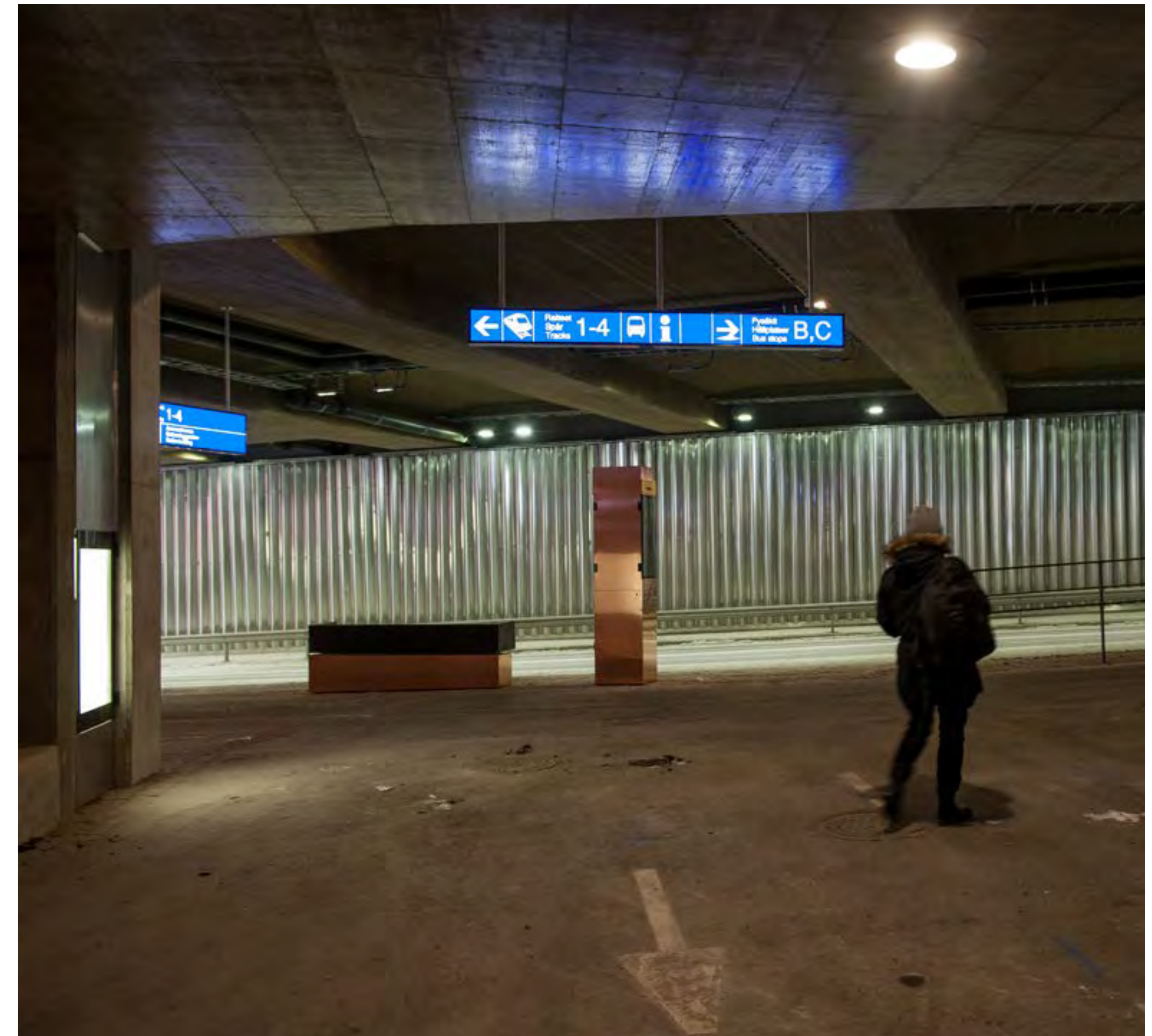
Kuva 12. Lahden asematunneli Vesijärvenkadun suuntaan (Tanhua 2016)
