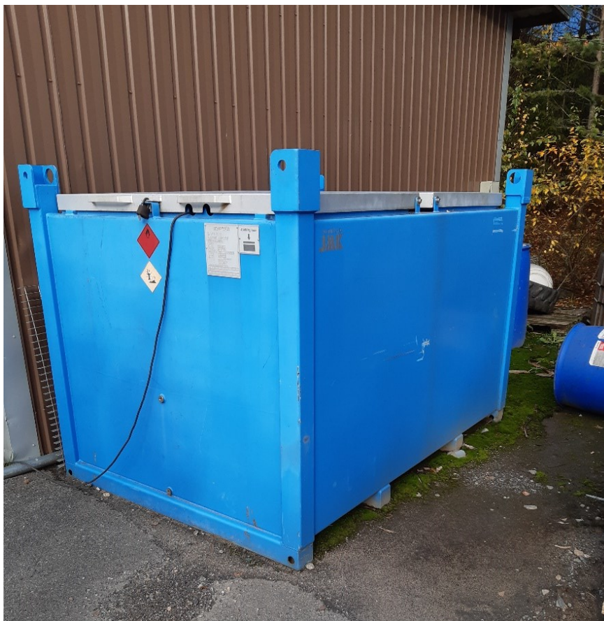
KUVA 12. Polttoainesäiliön vierestä puuttuu imeytysaine (Mutanen, 2020).
