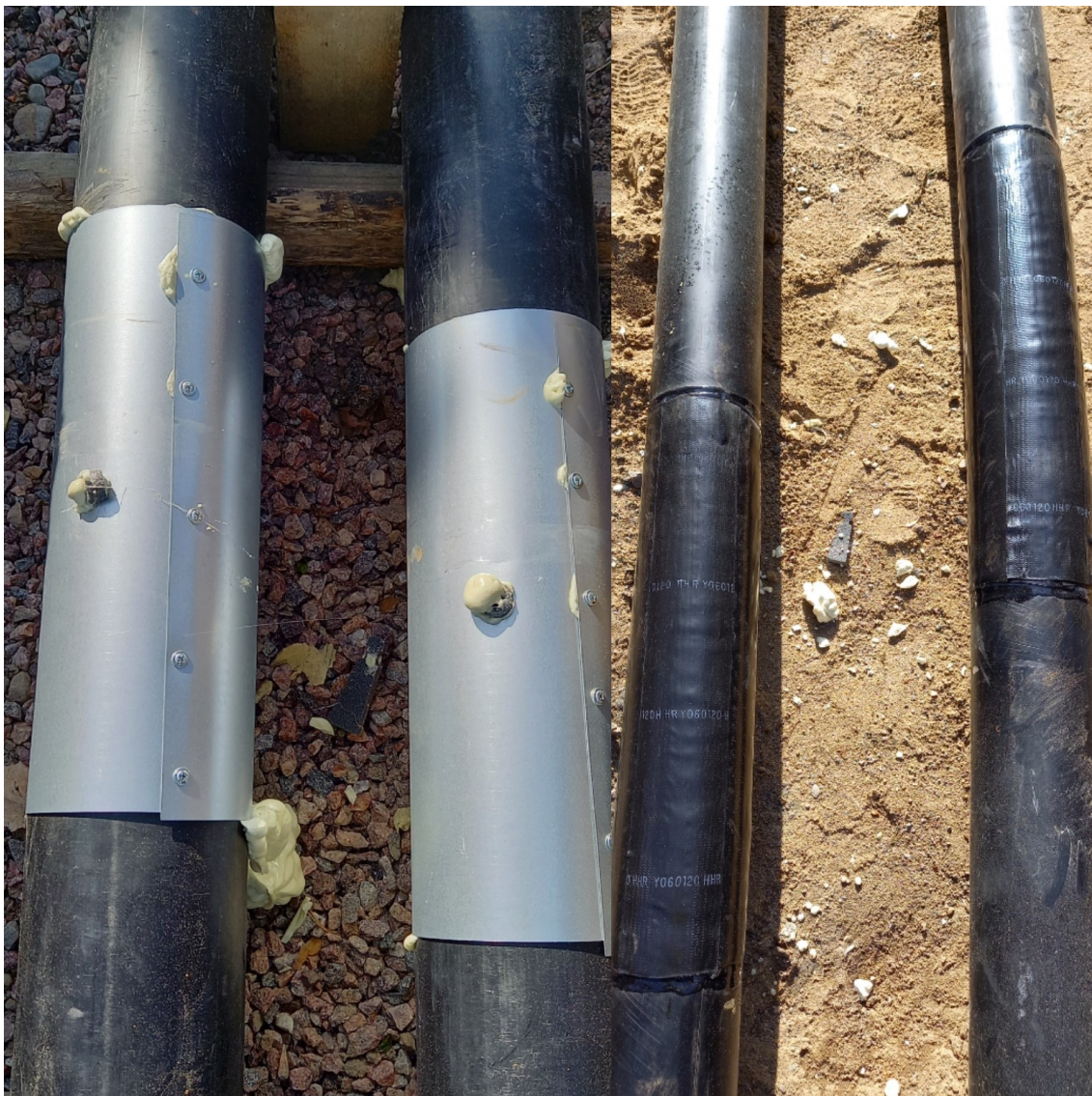
Kuva 6. Peltijatkoksen työvaihekuvat. Vasemmalla pelti ja polyuretaani asennettuna ja oikealla kutiste ja saumalappu asennettuna.
