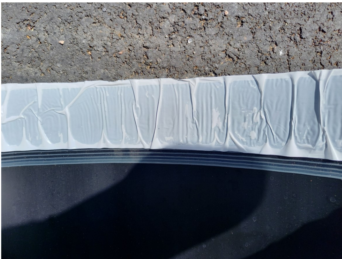
Kuva 14. Kuvassa näkyy Cegan MTM+ -holkin kuumaliima ja mastic-liima suojamuovin alla.
