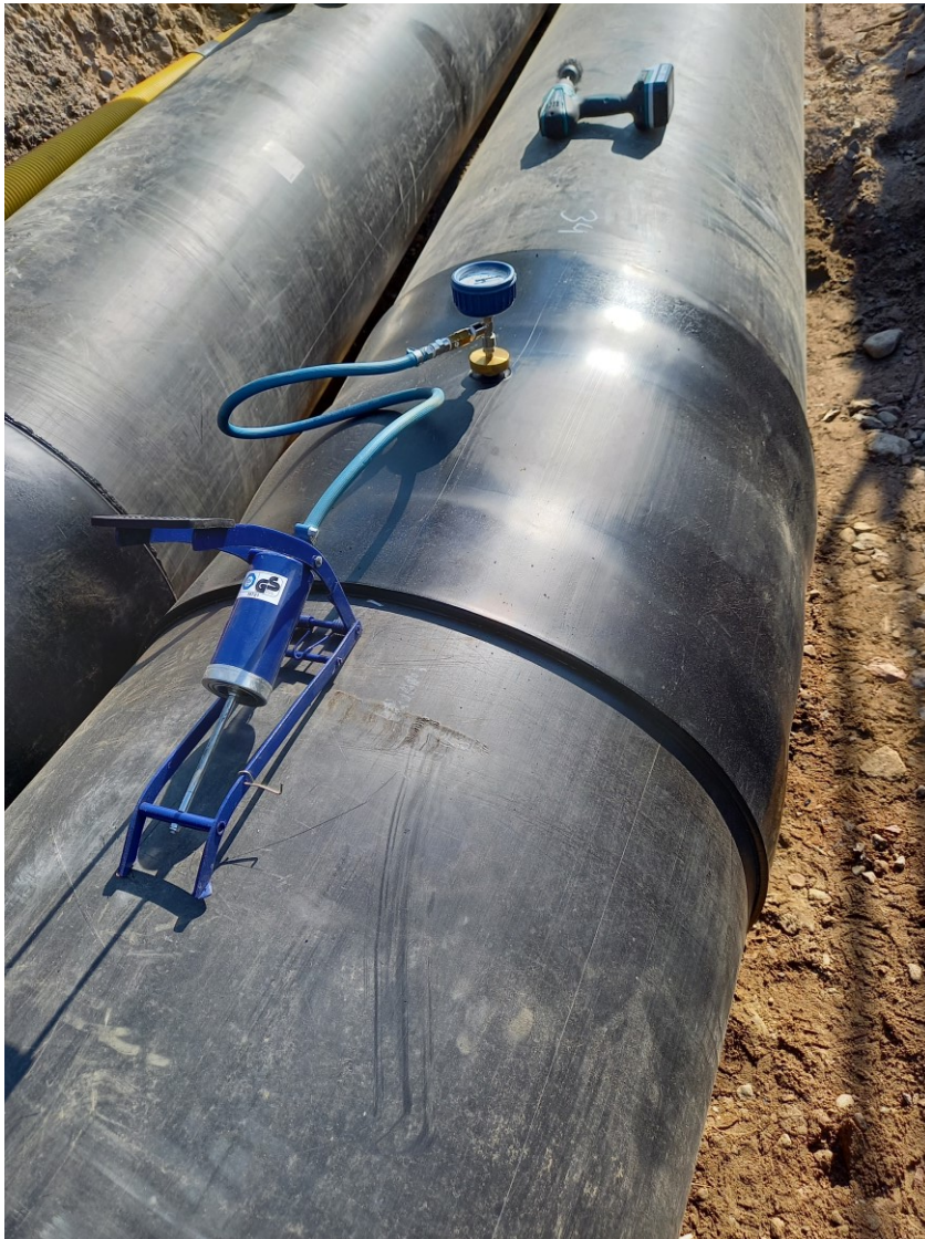
Kuva 12. Kutistuvan holkin testauslaitteet asennettuna.
