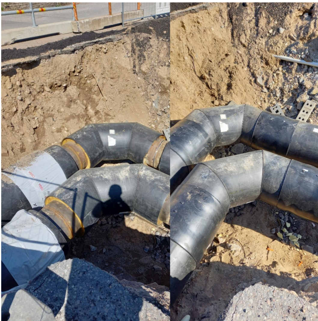
Kuva 10. Vasemmalla kuvassa kaukolämpöputket on hitsattu yhteen ja valkoisissa suojauspeitteissä olevat holkit pujotettu valmiiksi putken päälle. Oikealla holkit valmiina liitoksena.
