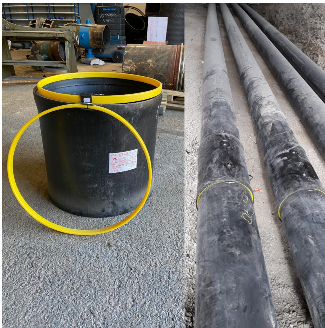
Kuva 8. Vasemmalla kuvassa SWJ-holkki ja vastus langat. Oikealla SWJ-holkki valmiina liitoksena.
