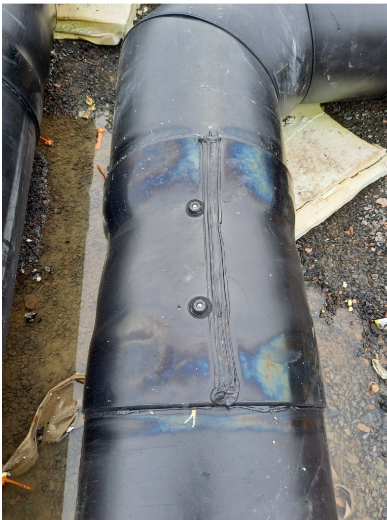
Kuva 9. Halkaistu Cega MTM+ -holkki, joka on halkaistu ja muovihitsattu kiinni.
