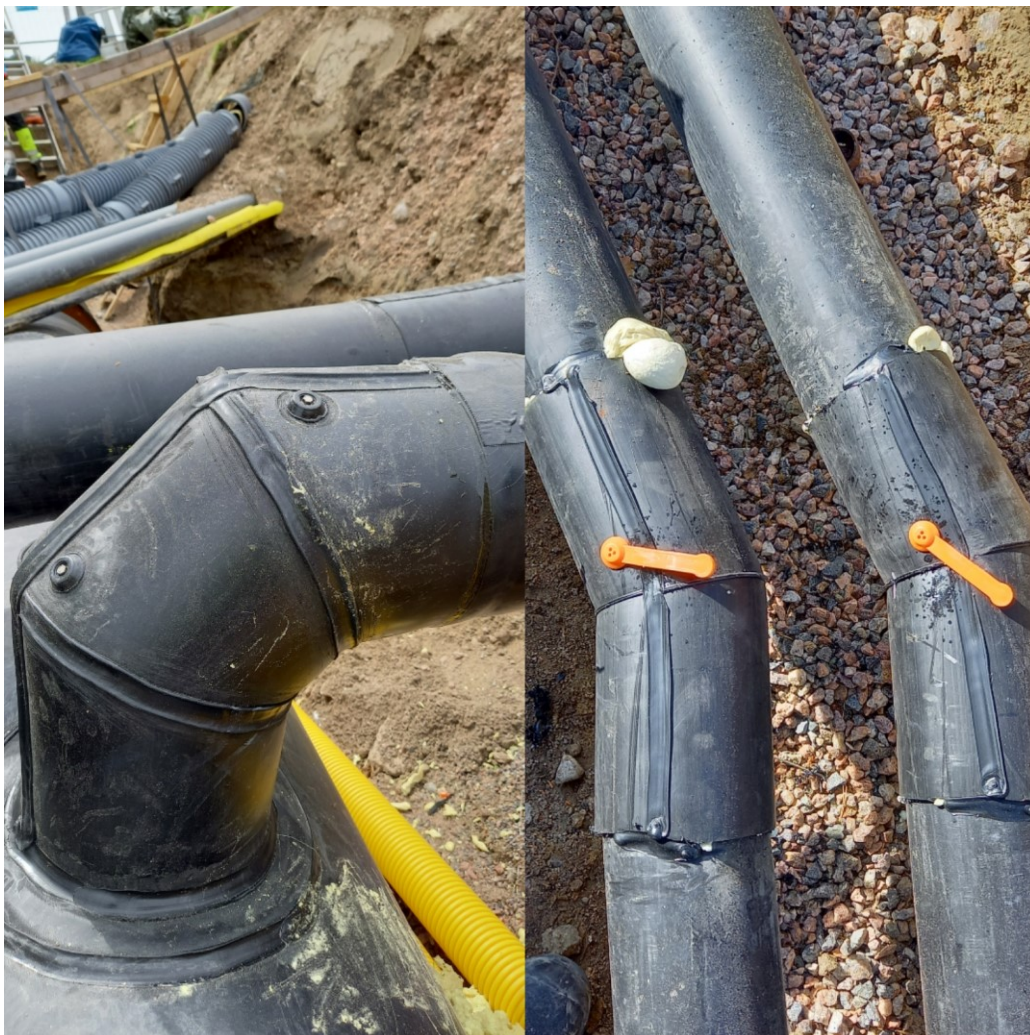
Kuva 7. Vasemmalla muovihitsattu haaroituskappale ja oikealla muovihitsattu kulmakappale.
