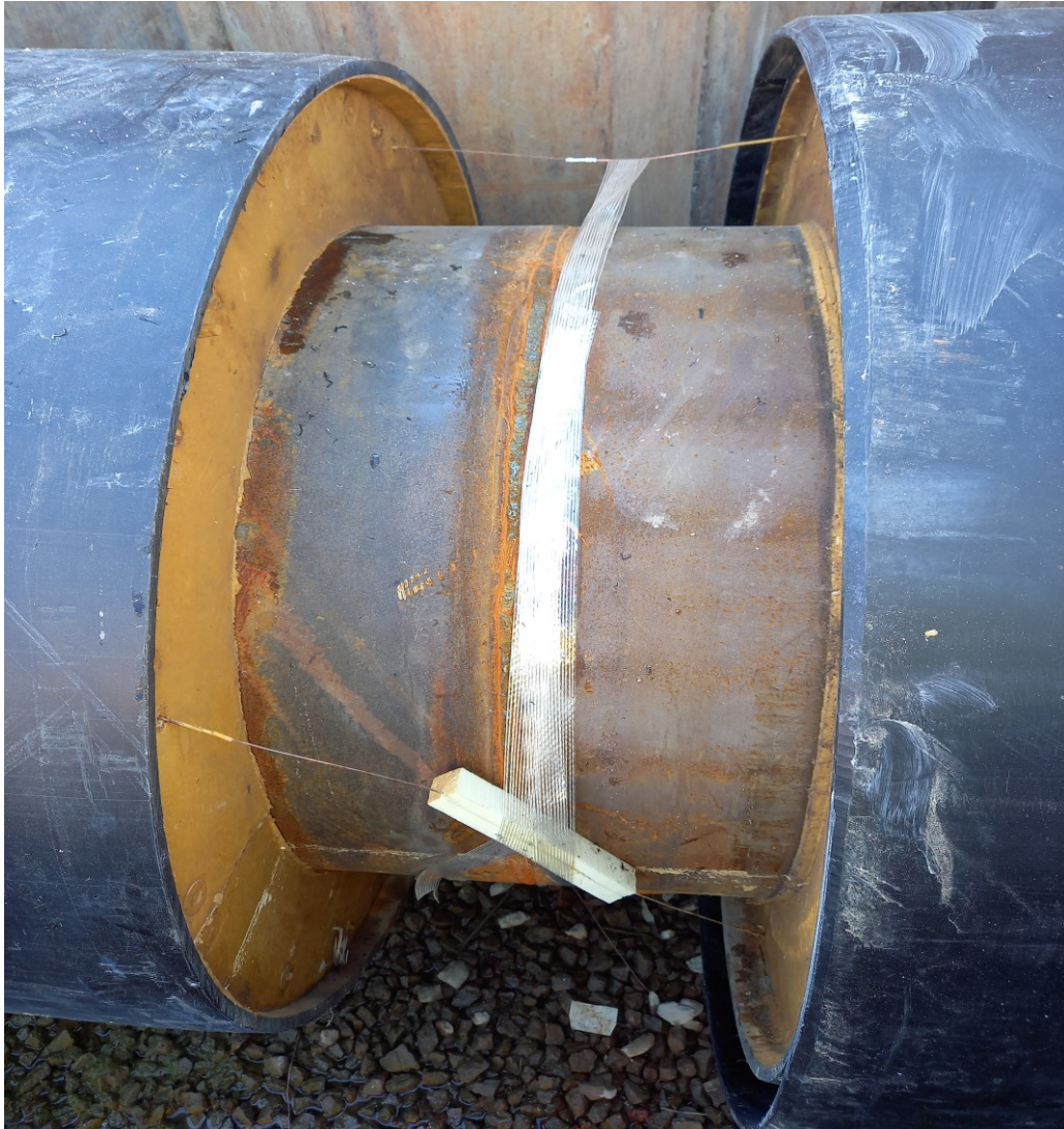
Kuva 11. Kuvassa näkyy kytketyt hälytysjohtimet.
