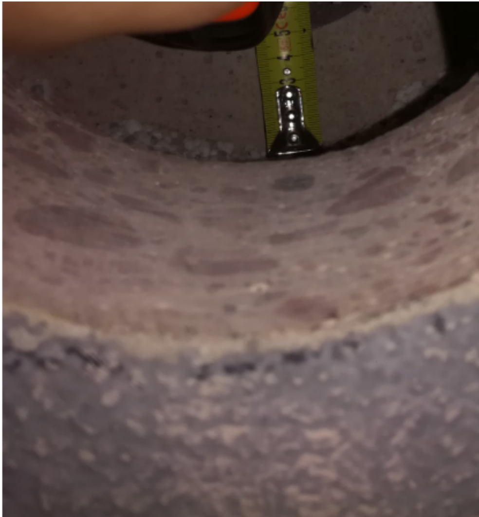
Figur 26. Hålet genom väggen, borttagande av isolering.
