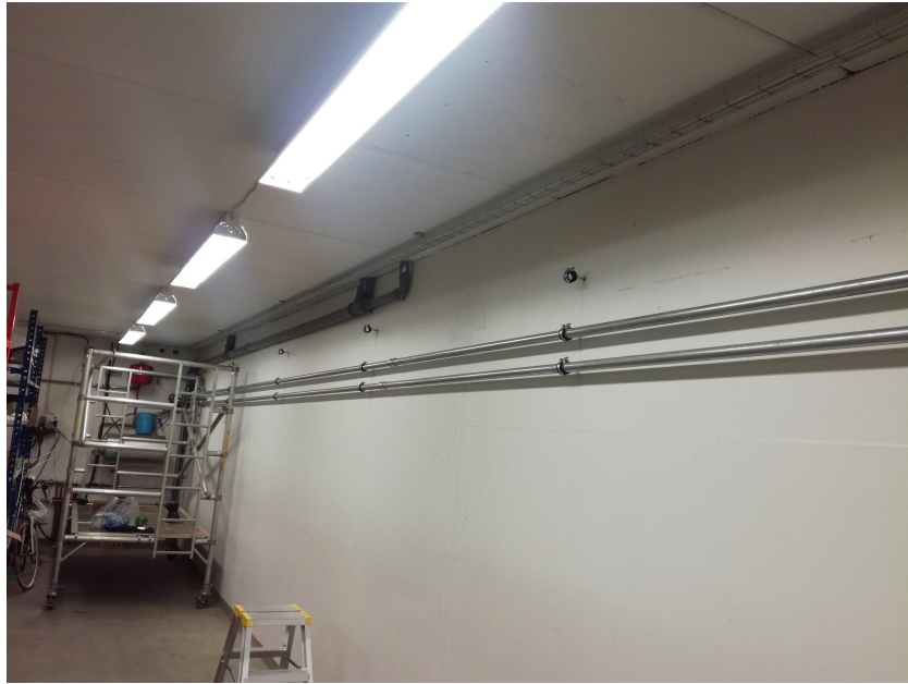
Figur 28. Upphängning av värmerören.
