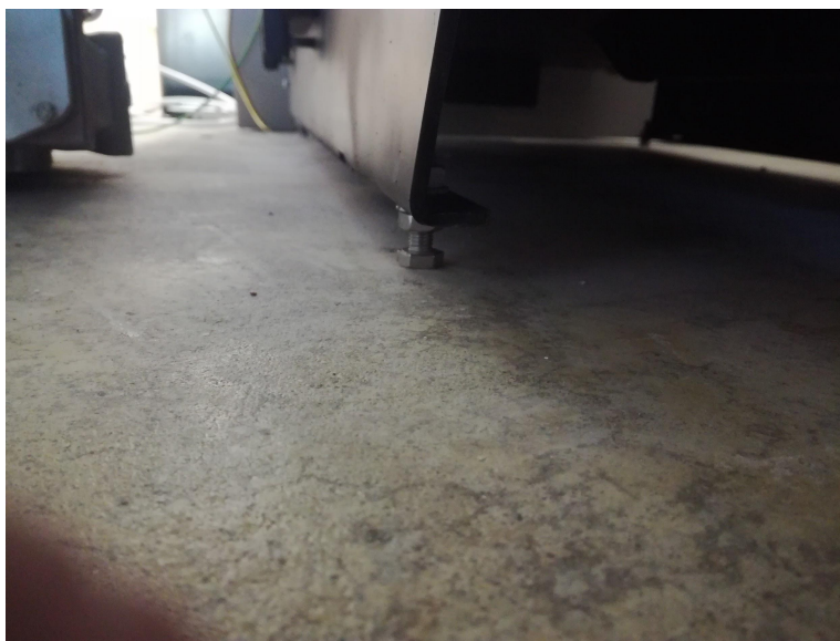
Figur 34. Fötter till pannan för att justera den rak.
