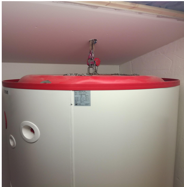
Figur 31. Upphöjning av ackumulatortank.
