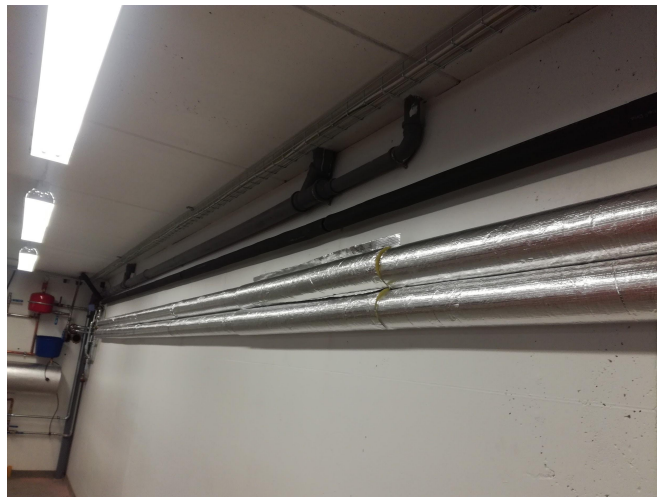
Figur 29. Aluminiumarmerad rörisolering.
