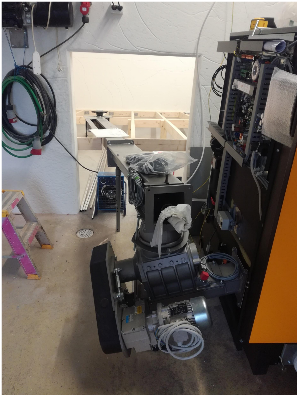
Figur 38. Skruven och pannan monterade.
