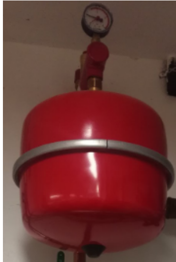
Figur 5. Befintligt expansionskärl.
