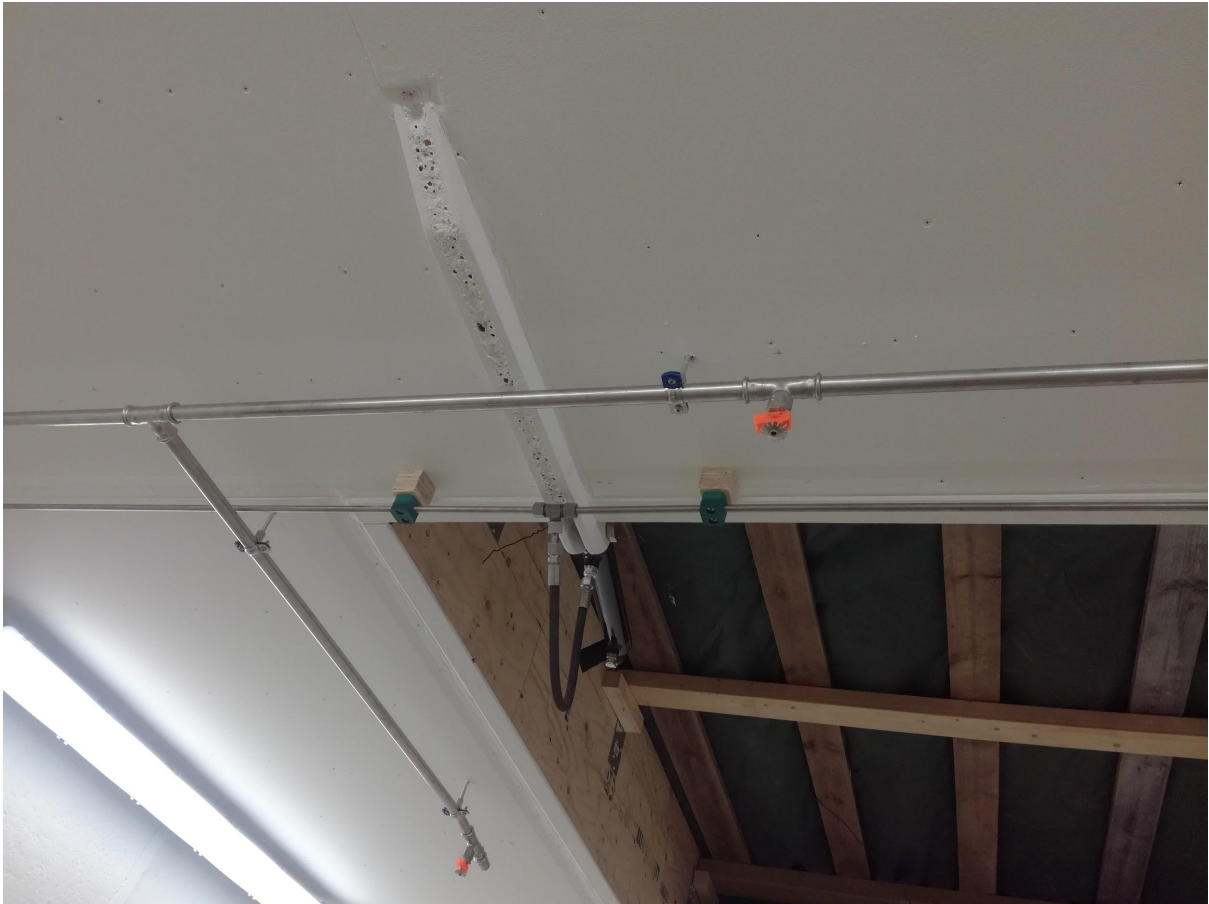
Figur 30. Sprinklermontering i flislagret.
