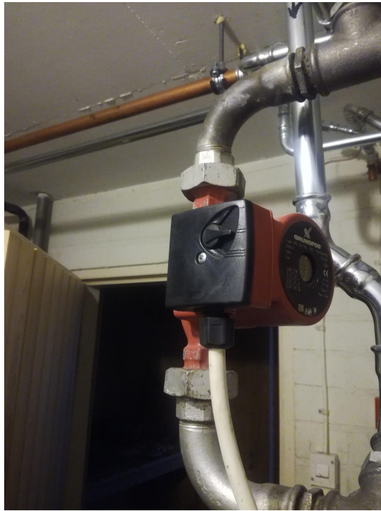
Figur 16. Grundfos cirkulationspump.
